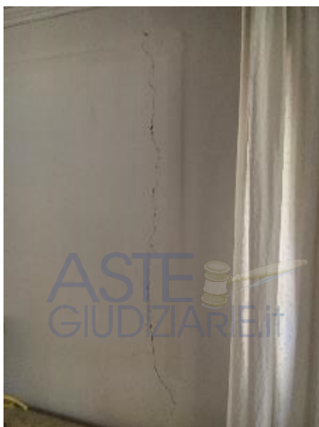
La lesione sull'intonaco presente nella stanza che affaccia verso il Viale di Castel Porziano
