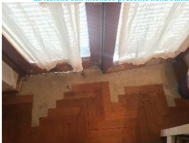
Il distacco dei listelli di parquet nella stanza in aderenza a quella di cui sopra e le tracce di umidità nel soggiorno
