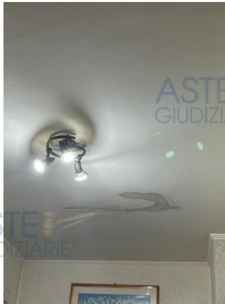
Le porzioni di soffitto in questione
