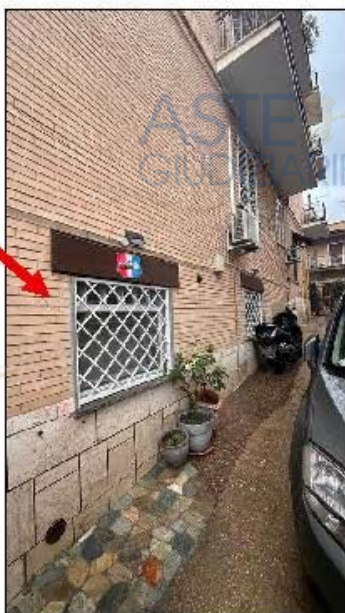
5 - accesso carrabile trasformato in finestra
