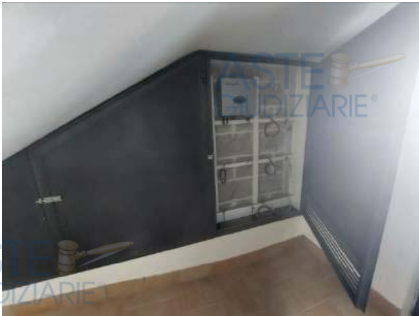
Gli armadi per l'alloggiamento degli inverter
