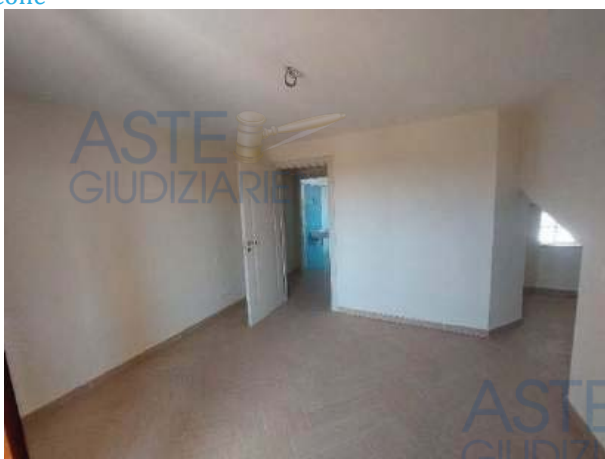
Il locale tecnico
