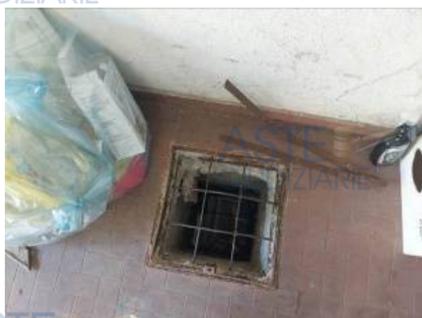
Il pozzetto e la griglia posta al termine della rampa
