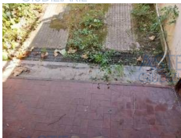
Il pozzetto e la griglia posta al termine della rampa
