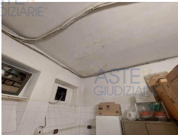
I fenomeni legati alle infiltrazioni al piano nel sottosuolo
