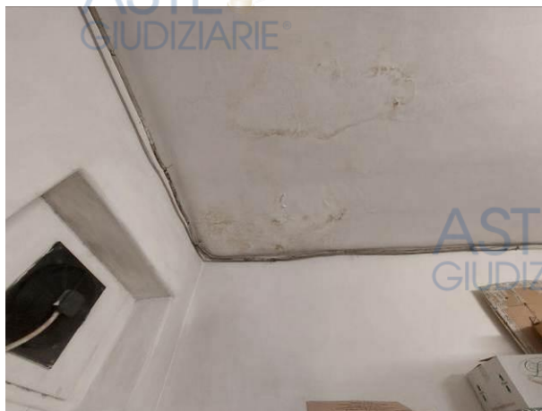
I fenomeni legati alle infiltrazioni al piano nel sottosuolo
