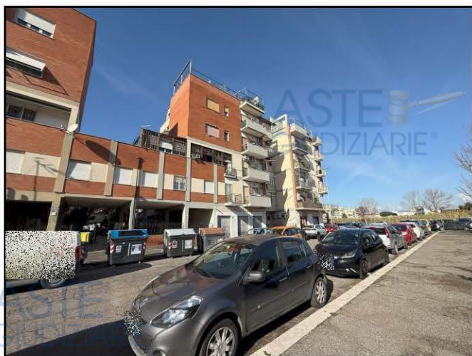
Vista del fabbricato D su Via Capo Palinuro
