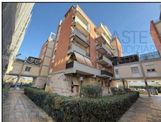
Vista del fabbricato D dal cortile interno
