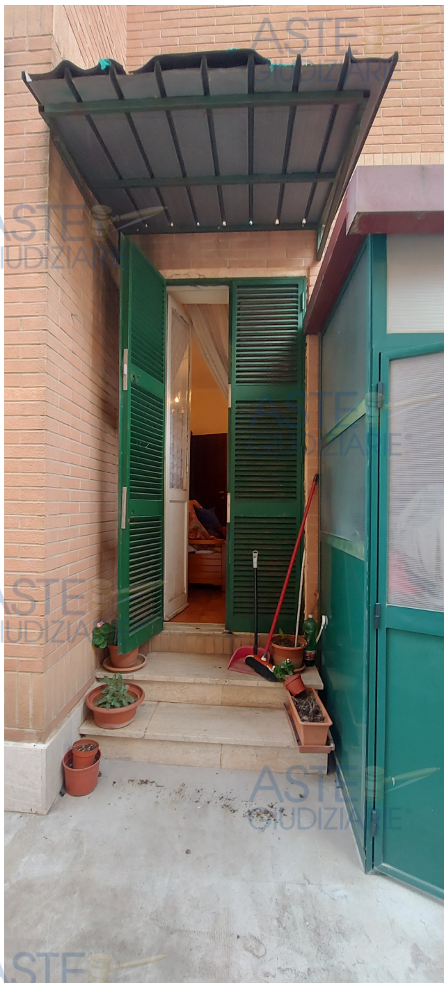
Situazione attuale - Piano primo (rialzato). Particolare del varco murario (con soprastante tettoia)
