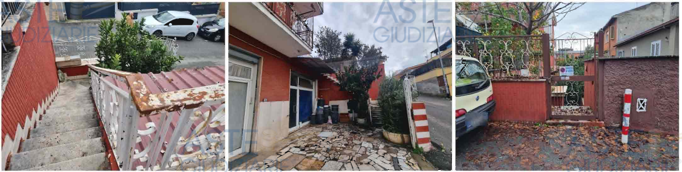
VISTA RAMPE INTERNE E INGRESSO SECONDARIO
