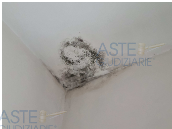
DETTAGLIO ANGOLO BAGNO
