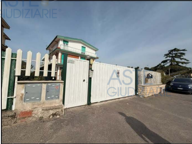
Vista del fabbricato su Via di Vermicino 186
