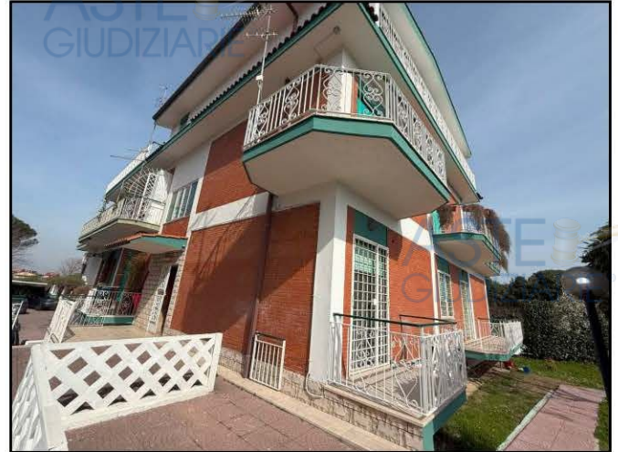
Vista esterna del fabbricato
