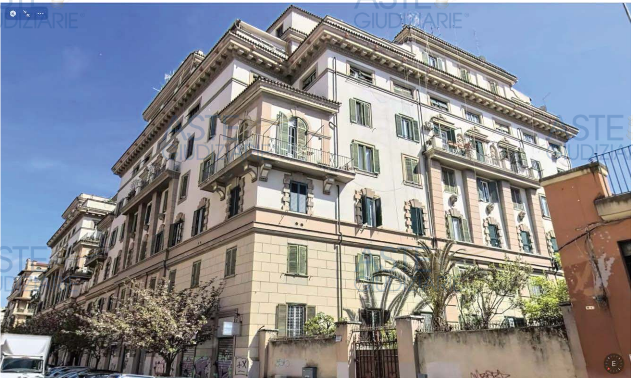
L'edificio visto da Via Terni (foto reperite sul sito google.it/maps )
