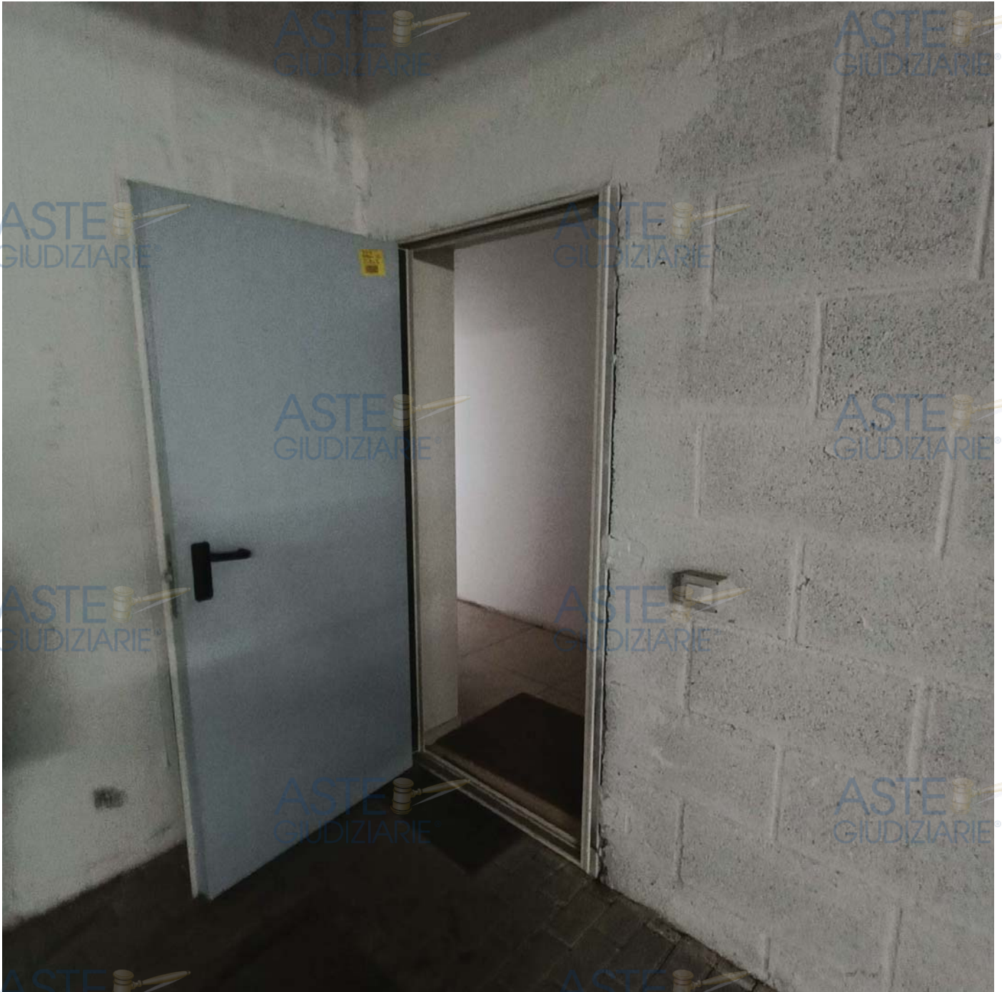
Porta d'Ingresso Locale deposito ad uso ufficio
