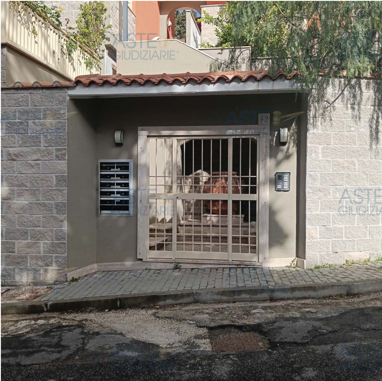
Ingresso pedonale da Via dei Maffei. 42
