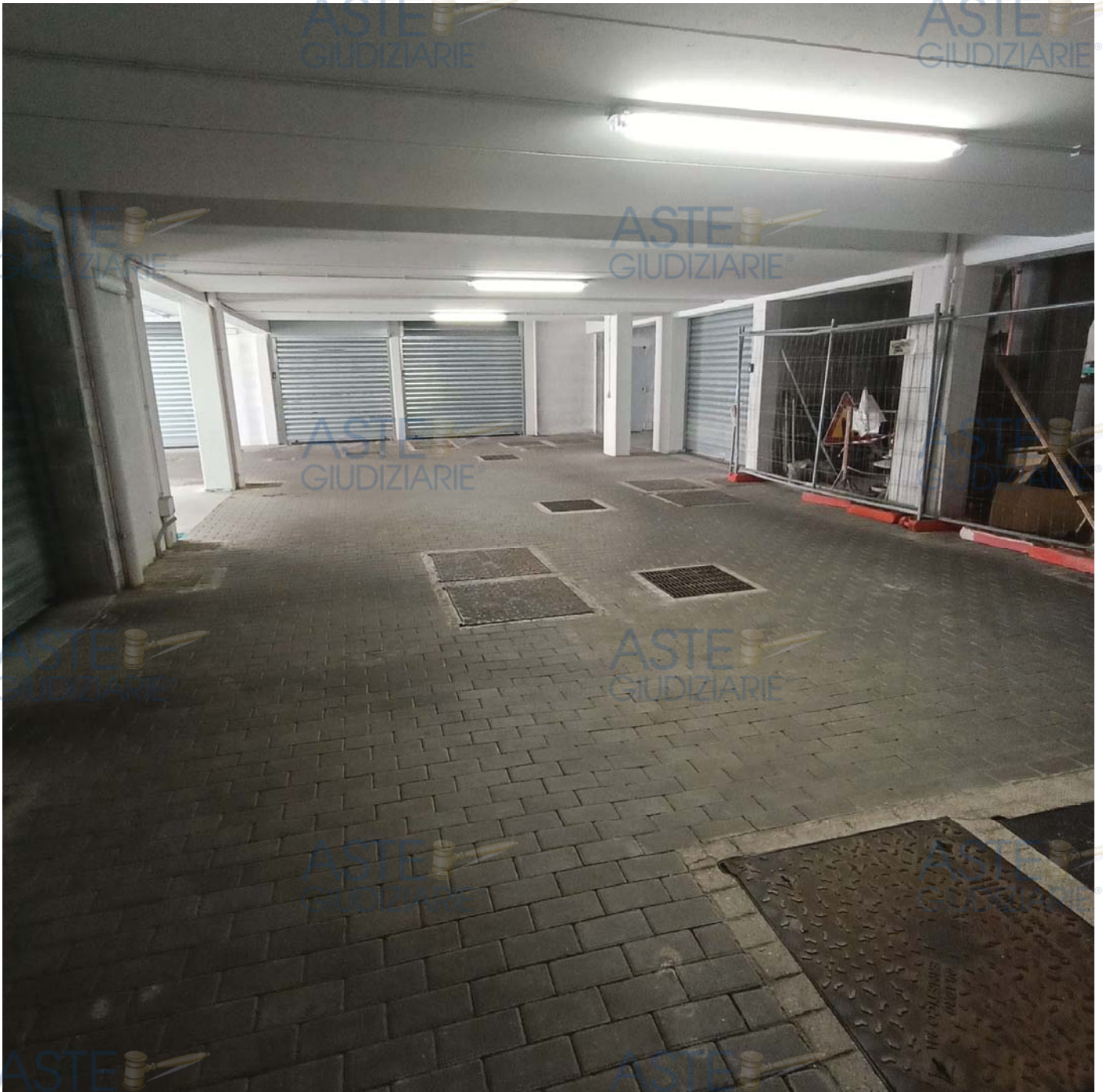
Area di manovra piano S1
