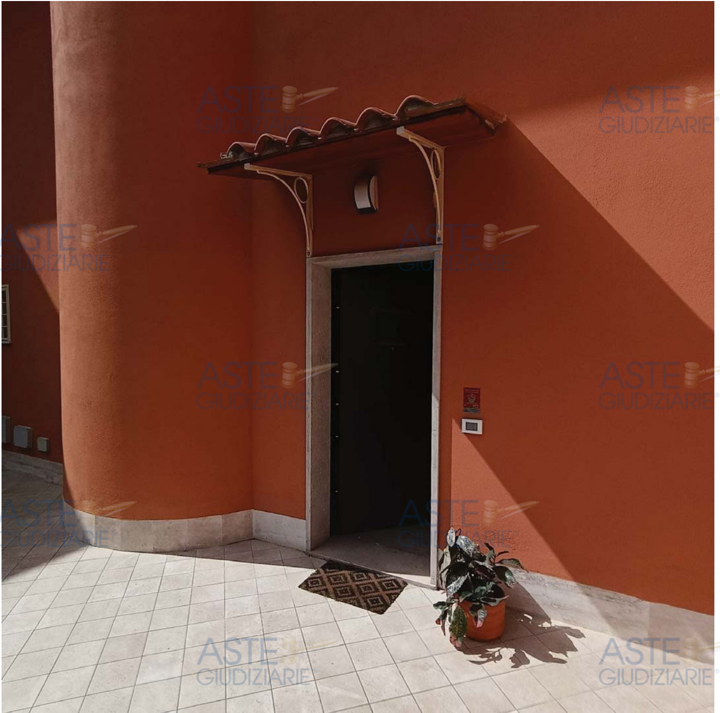
Portoncino ingresso Appartamento Interno. con accesso dalla Piazzetta condominiale
