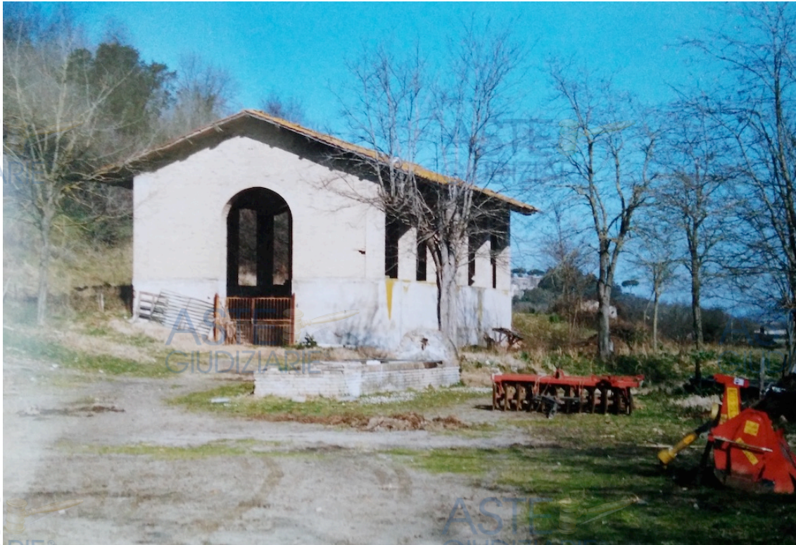
Fig. 3a - Vista del fienile prima della ristrutturazione
