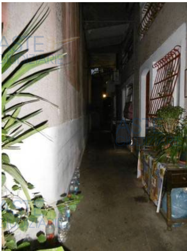
Lato spazio condominiale- intercapedine Via Stasi
