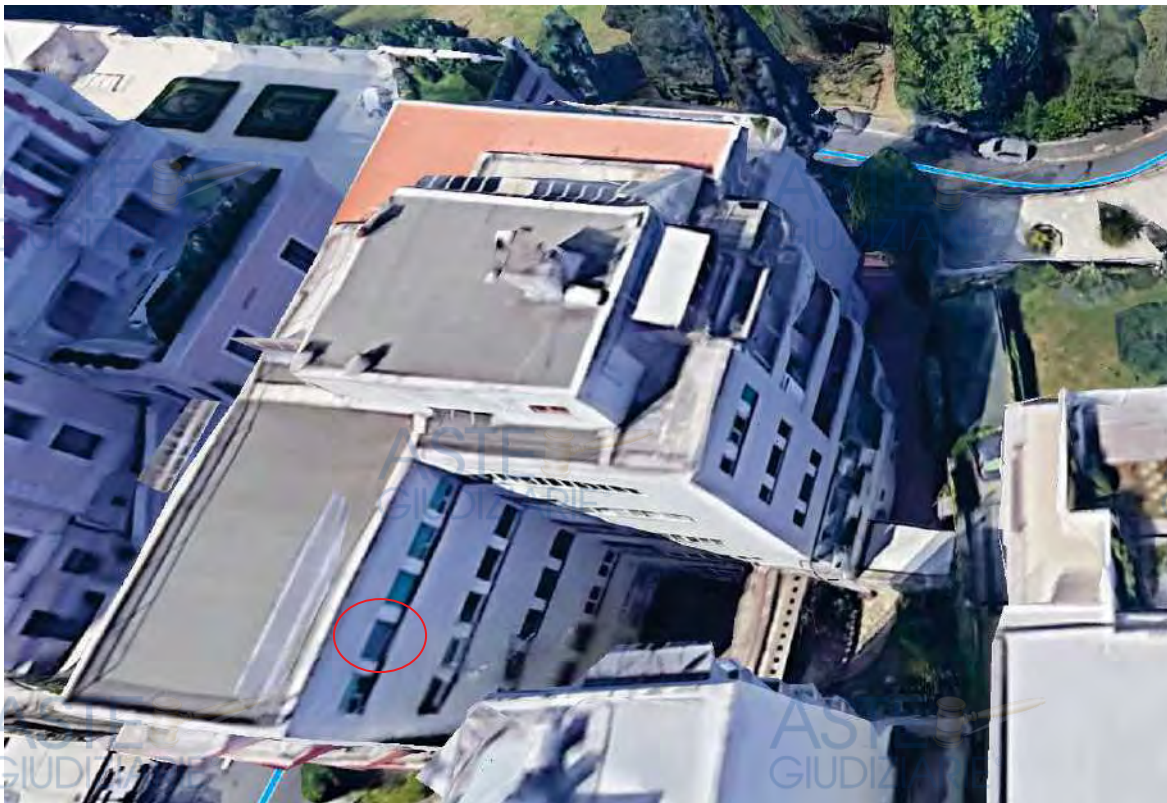
Finestra dell'antibagno chiusa all'interno ma visibile sul prospetto
