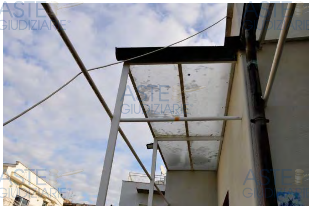
Coperture sul terrazzo
