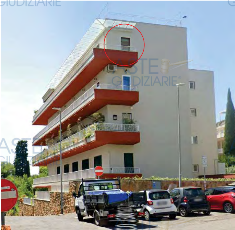
Porta finestra della camera da letto tamponata all'interno ma visibile sul prospetto laterale
