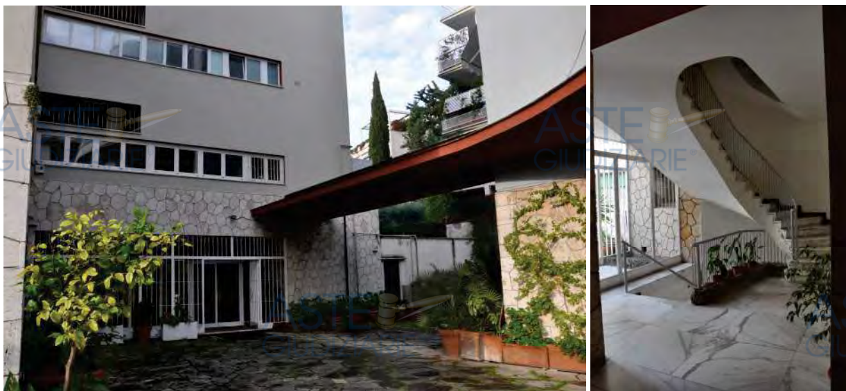
Ingresso all'edificio e androne condominiale
