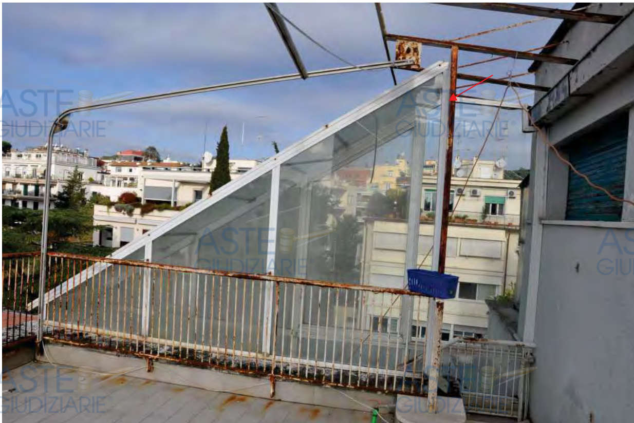
Chiusura della scala esterna
