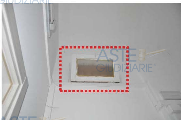
Finestra nel bagno
