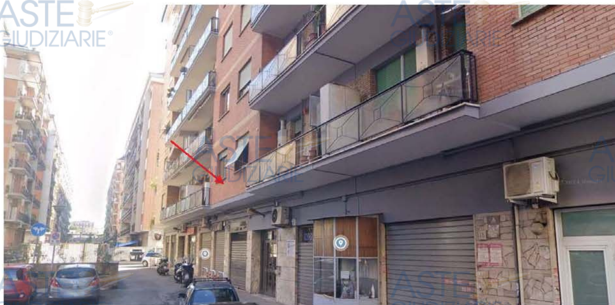
Edificio in esame
