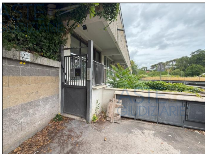
Accesso pedonale su P.zza Passo del Pordoi 22
