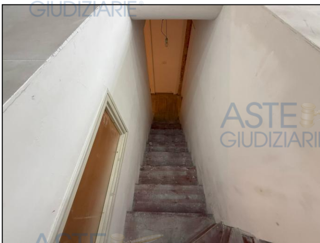
Scale di accesso al piano S1
