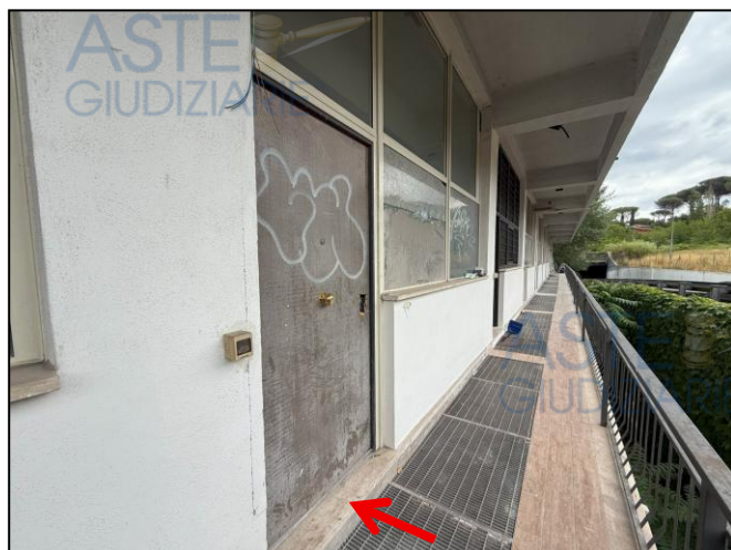
Accesso dal ballatoio comune
