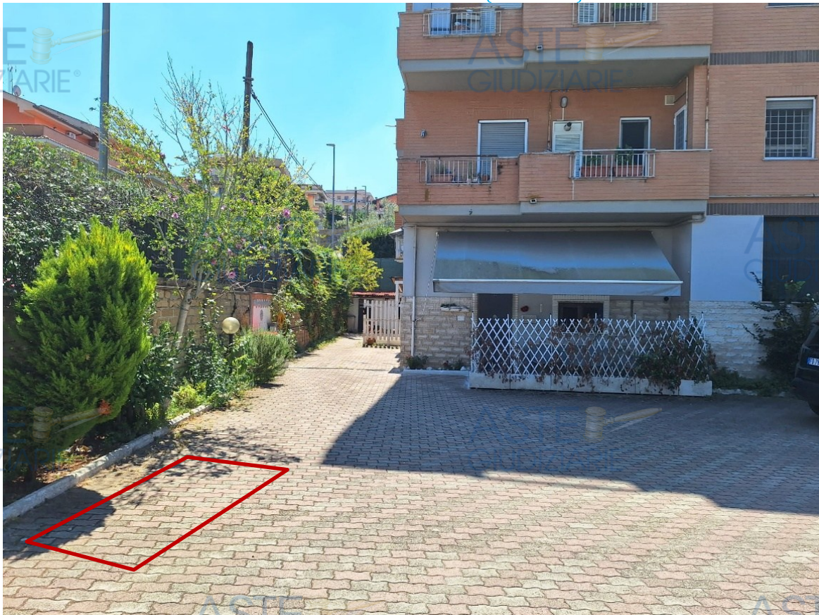
Posto auto scoperto identificato catastalmente con il sub 509
