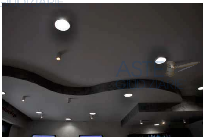
Controsoffitti locale negozio
