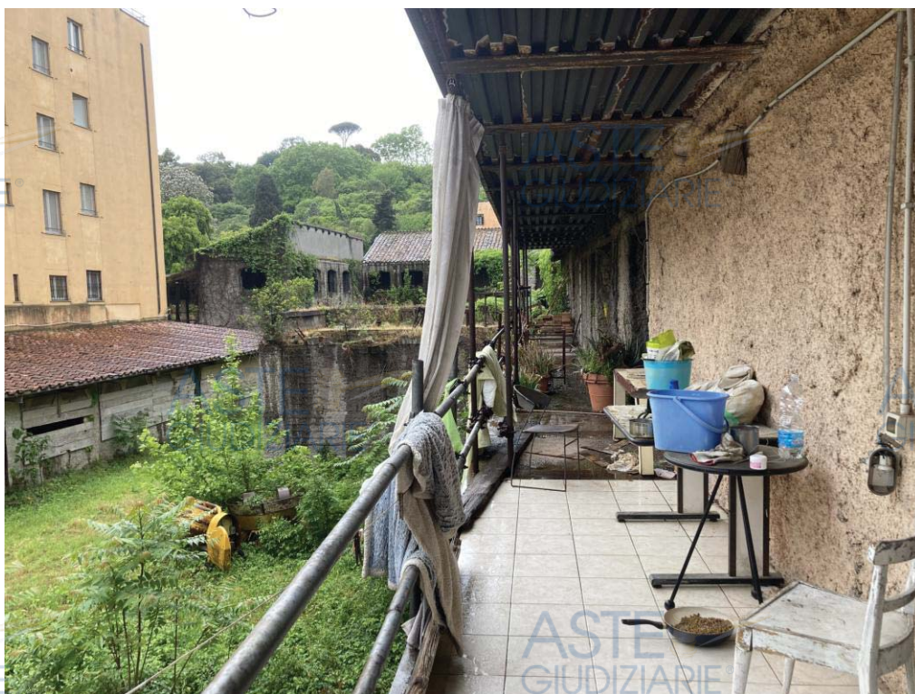
il balcone a sbalzo al piano primo, con affaccio sul cortile
