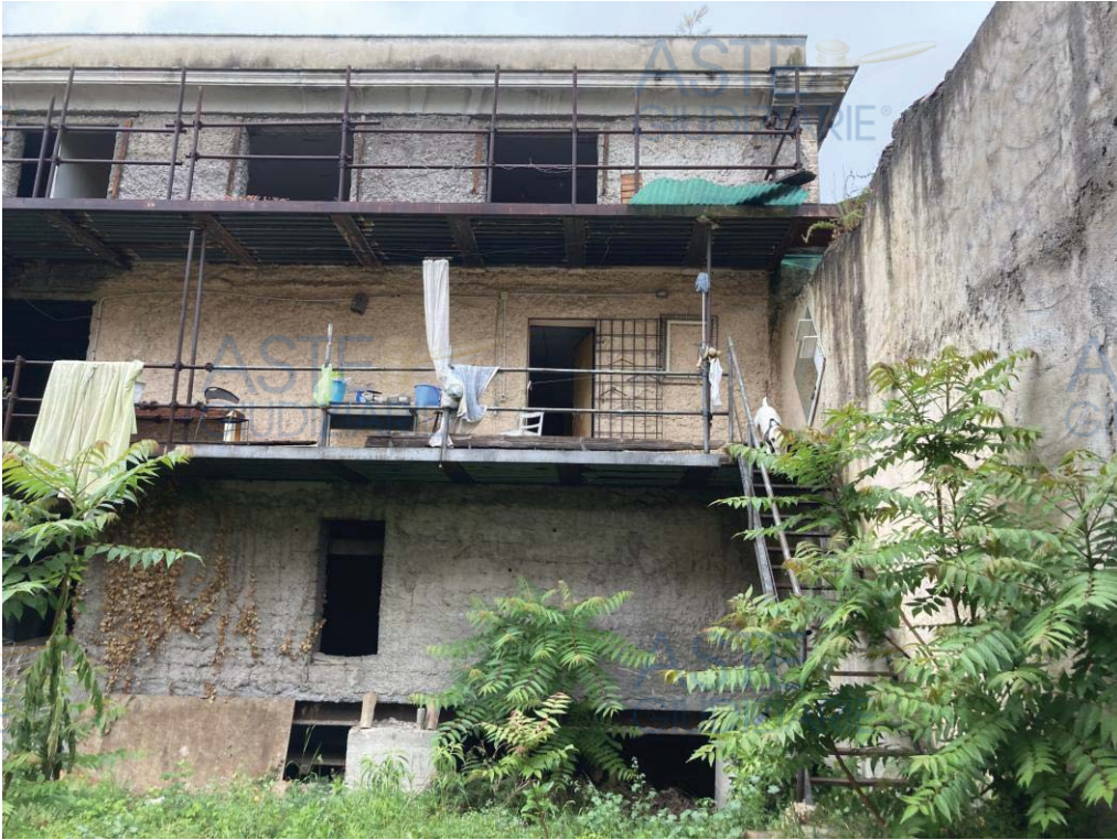
i balconi a sbalzo nell'edificio A, al piano primo e al piano secondo
