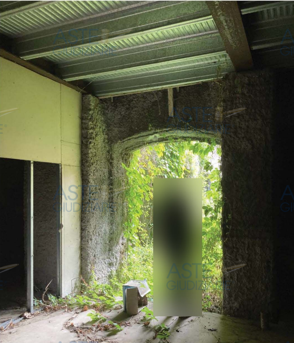
un solaio in pannelli OSB fatiscente al piano terra, e l'intradosso dei solai abusivi negli edifici E e D
