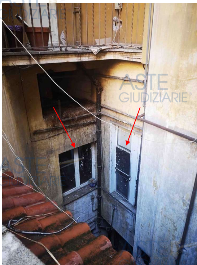
Vista delle finestre dell'abitazione dalla chiostrina interna – foto 40
