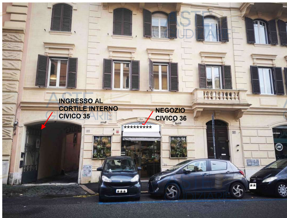
Prospetto del fabbricato su via di Porta Castello – foto 4
