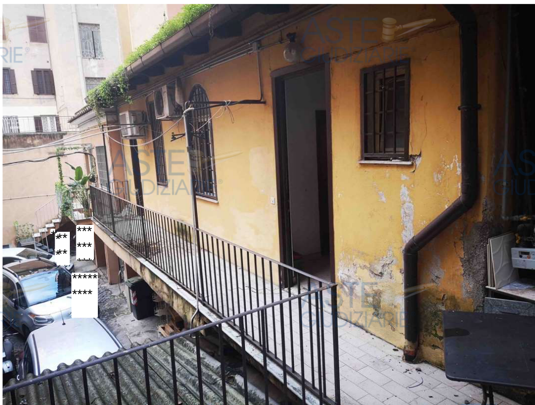
Esterno dell'unità immobiliare – foto 28
