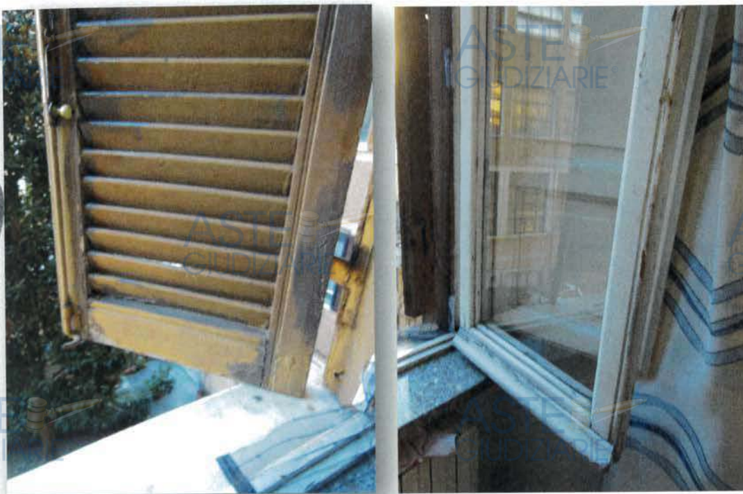
FOTO 06 - 07 VISTA PARTICOLARE SERRAMENTI ESTERNI
