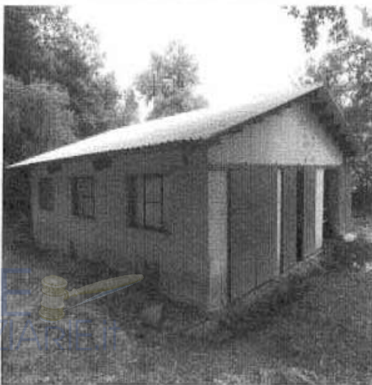
FOTO 3: IMMOBILE NCEU LABRO F.7 , P.476 , PARTE 3 PROSPETTO Nord – Ovest.
