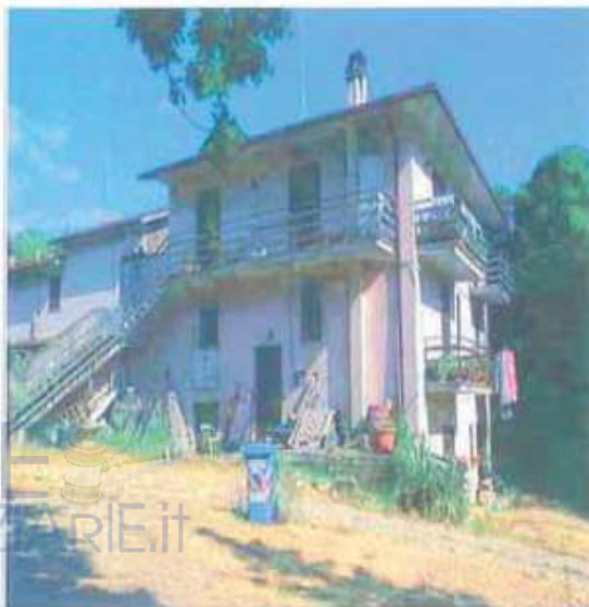
FOTO 3: PROSPETTO GENERALE SUBB. 1- 2- 3 Lato Nord-Ovest.
