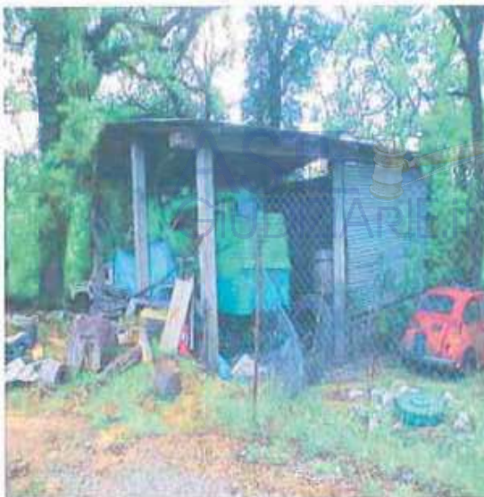
FOTO 2: INTERNO IMMOBILE NCEU LABRO F.7 , P.208 , SUB.5 – PROSPETTO Nord – Est.
