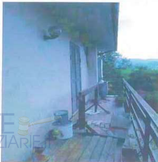
FOTO 9: INTERNO IMMOBILE NCEU LABRO F.7 , P.208 , SUB.2 – BALCONE LATO NORD.
