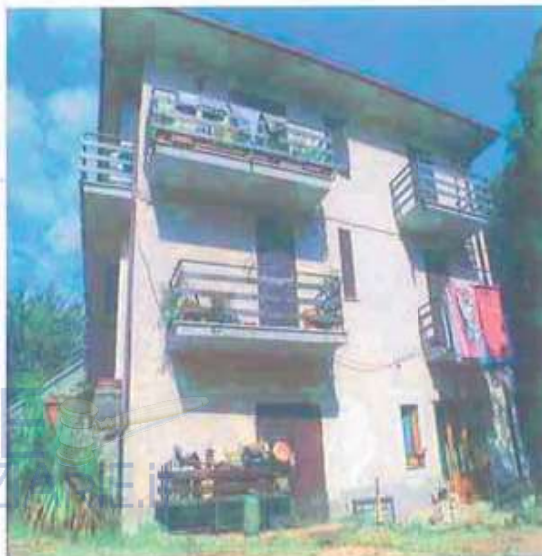
FOTO 1: PROSPETTO GENERALE SUBB. 1- 2- 3 Lato Ovest.
