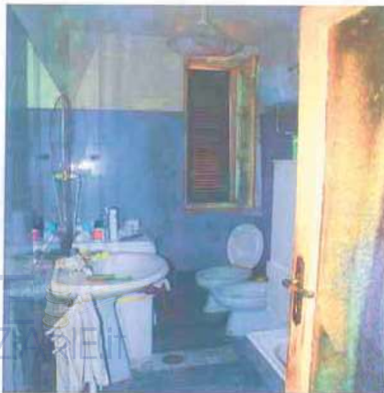
FOTO 5: INTERNO IMMOBILE NCEU LABRO F.7 , P.208 , SUB.1 – BAGNO.
