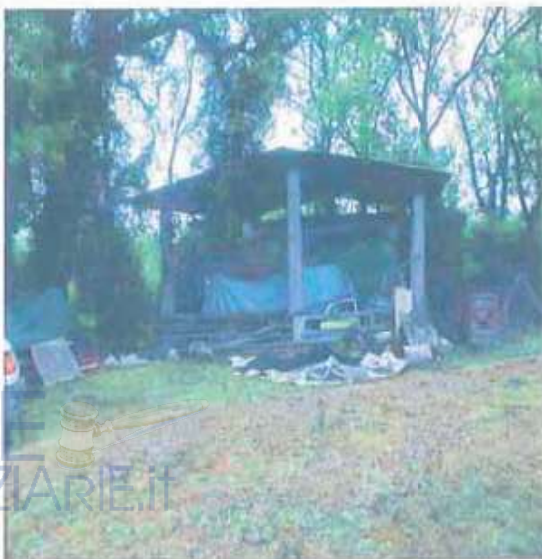
FOTO 1: IMMOBILE NCEU LABRO F.7 , P.208 , SUB.5 – PROSPETTO Est.
