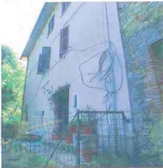
FOTO 5: PROSPETTO GENERALE SUBB. 1- 2- 3 Lato Sud.
