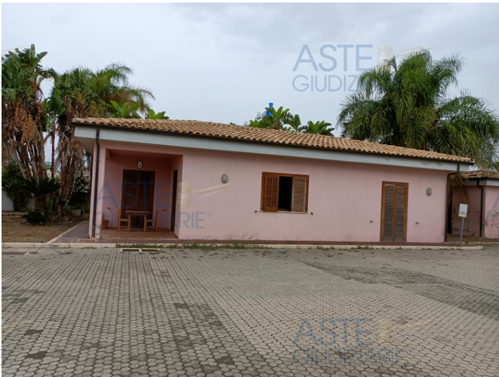
Foto n. 51 – Corpo F – Alloggio custode.
