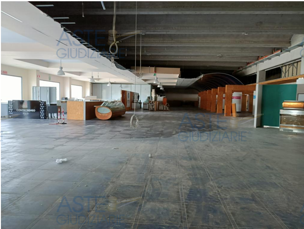
Foto n. 34 – Corpo B – Capannone – Sala esposizione.
