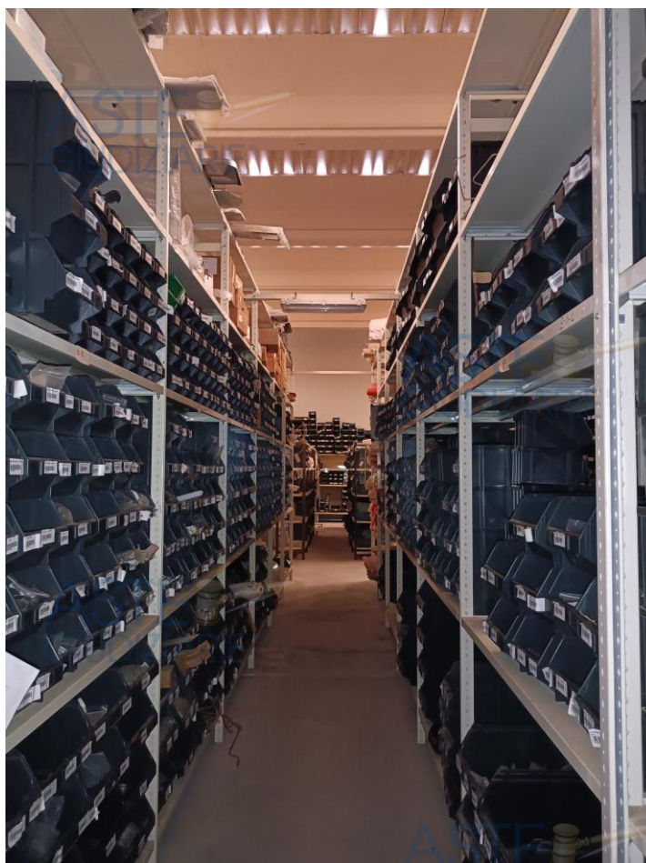
Foto n. 40 – Corpo C – Capannone – Magazzino.
