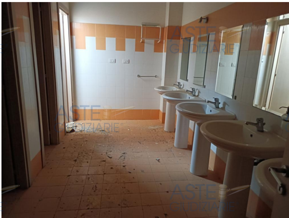
Foto n. 49 – Corpo E – Capannone – Mensa e servizi.
