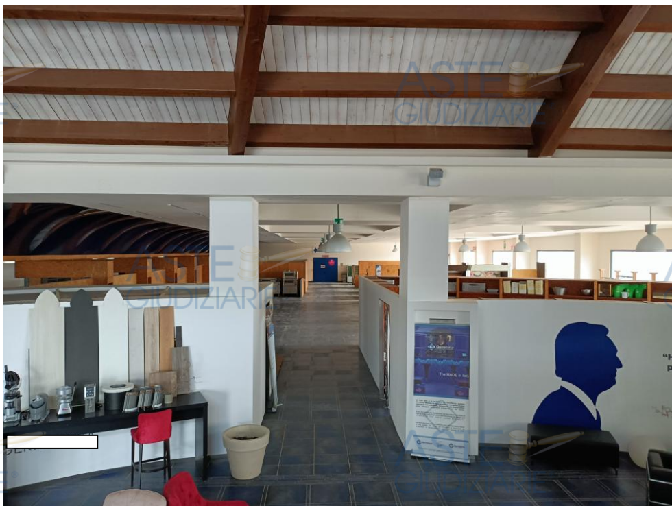
Foto n. 31 – Corpo B – Capannone – Sala esposizione.
