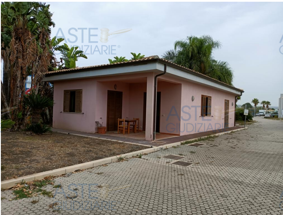
Foto n. 52 – Corpo F – Alloggio custode.
