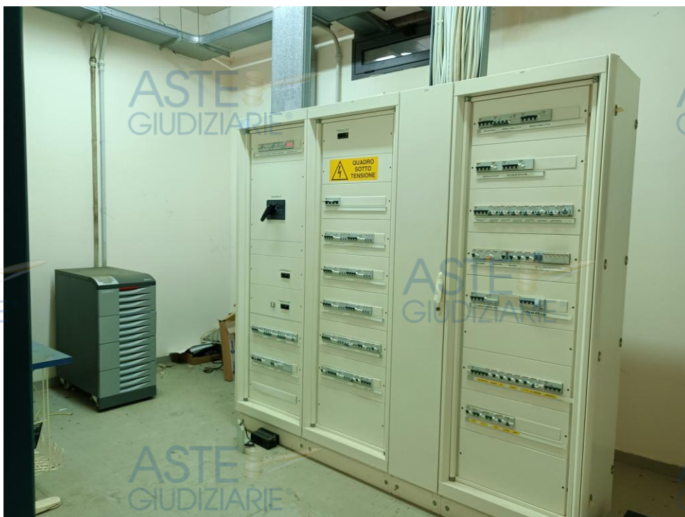
Foto n. 30 – Corpo A – Palazzina Uffici – Piano seminterrato.
