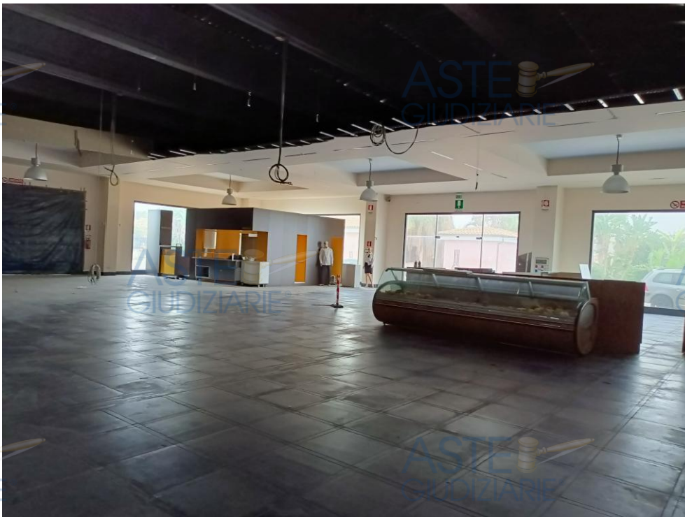
Foto n. 33 – Corpo B – Capannone – Sala esposizione.
