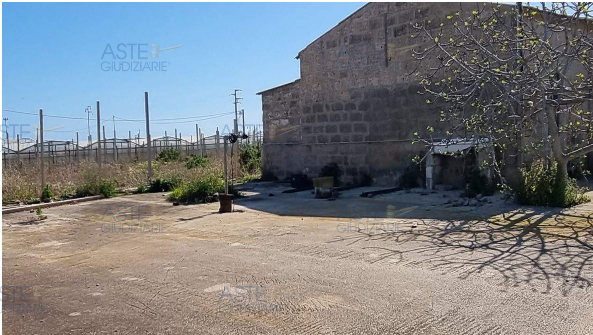
Foto n. 20 - Pozzo in prossimità del primo fabbricato (mappale 446/1)
