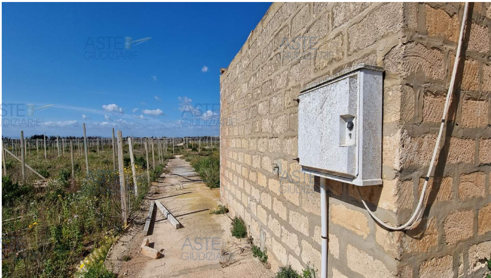
Foto n. 15 - Idem: prospetto laterale
