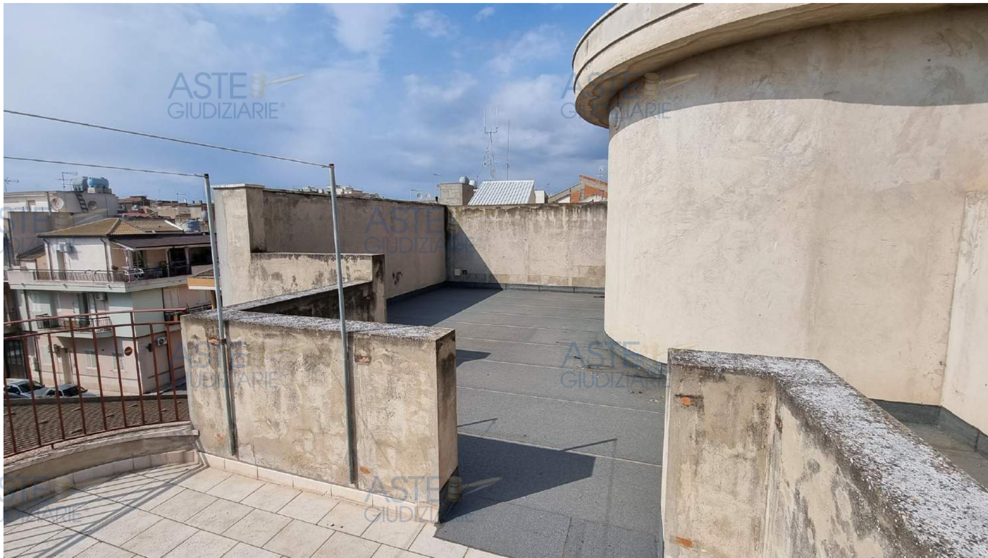
Foto n. 27 - Lastrico solare di Via Evangelista Rizza
