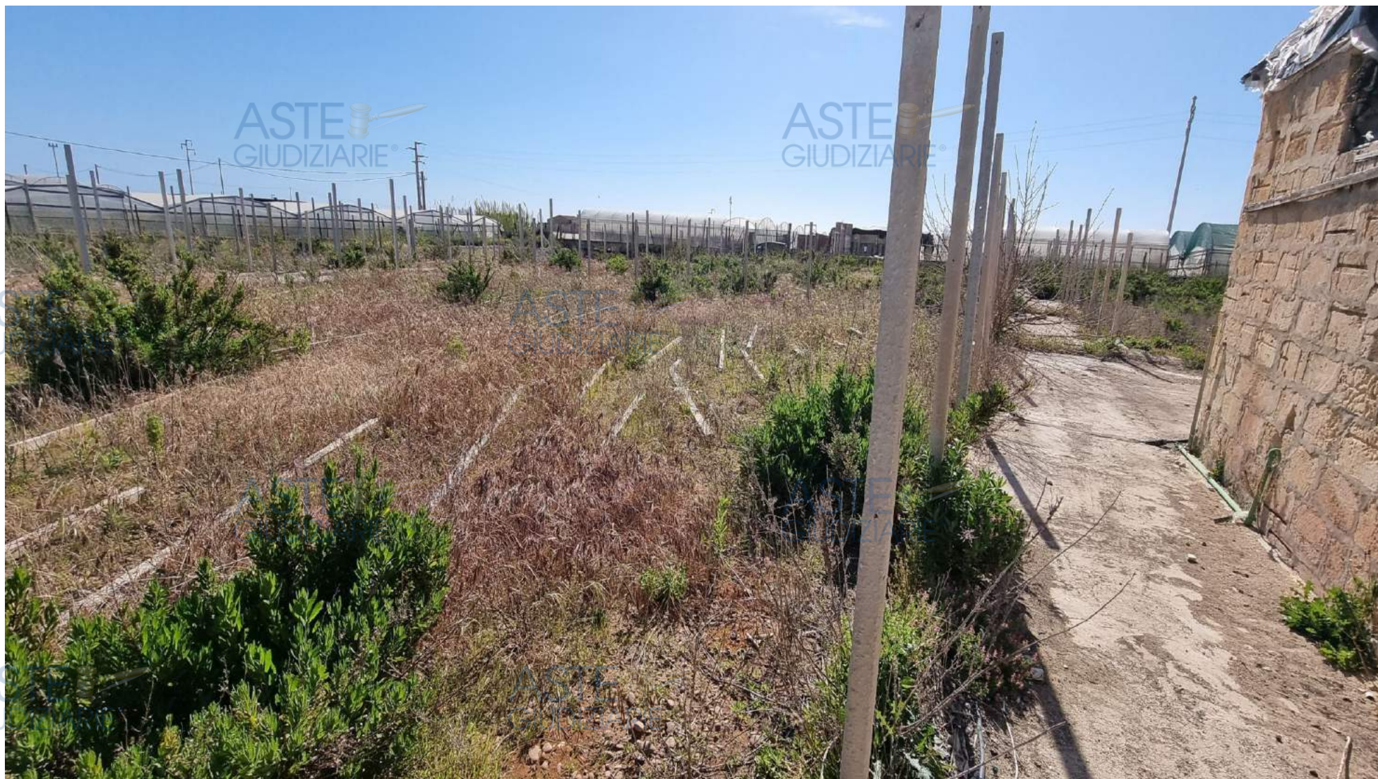
Foto n. 3 - Paletti in calcestruzzo prefabbricati
