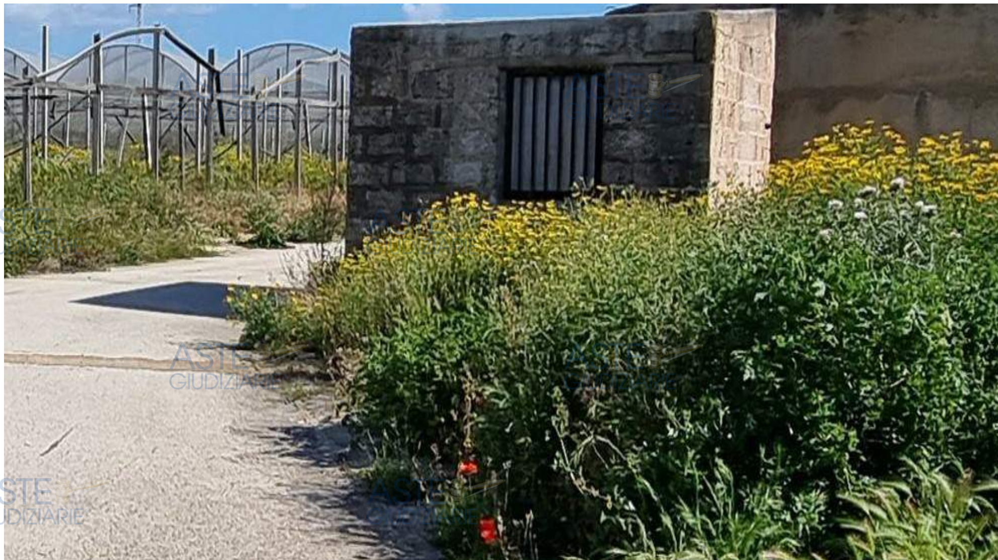
Foto n. 18 - Idem - Prospetto laterale
