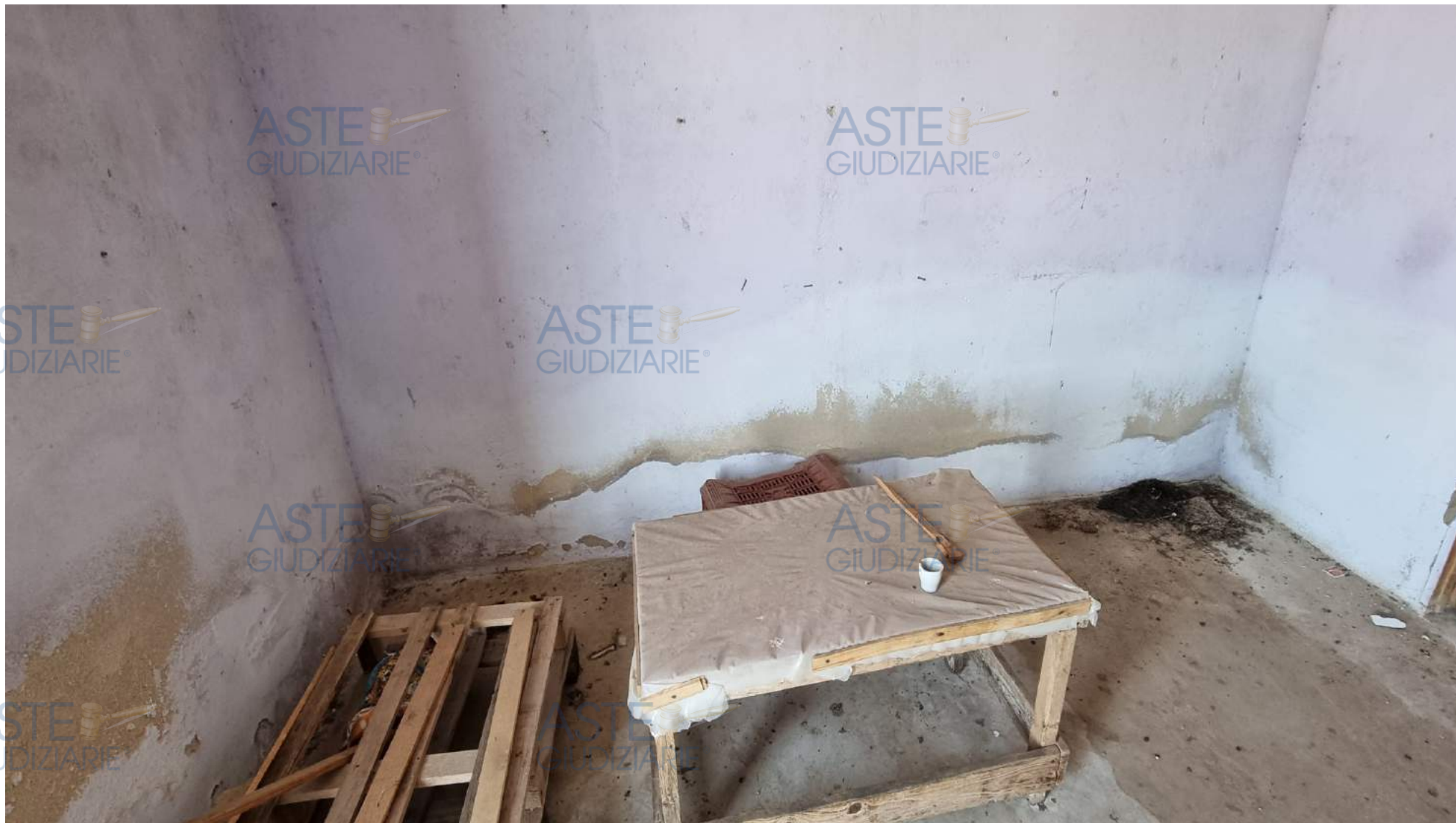
Foto n. 10 - Locale interno al fabbricato di cui sopra. Si notino gli intonaci scrostati e l'umidità di risalita
