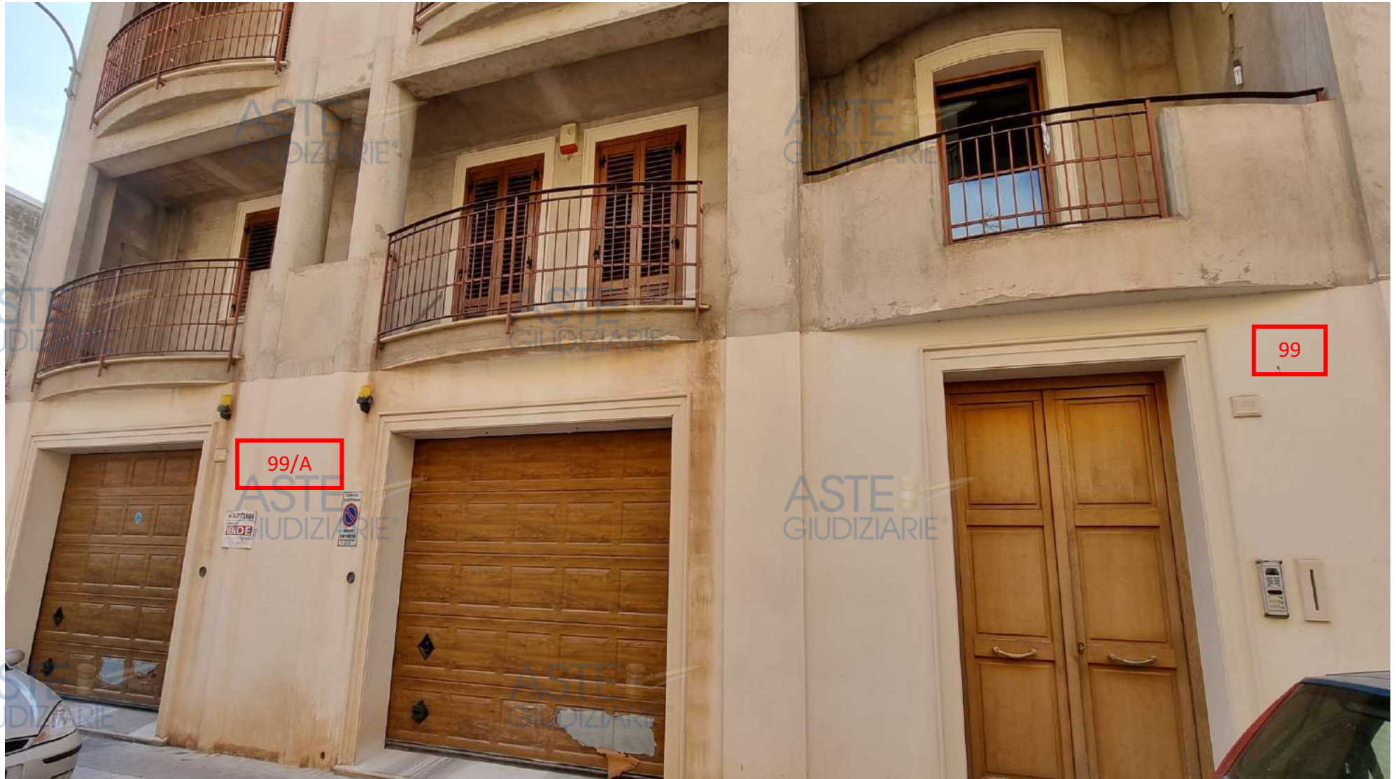
Foto n. 23 - Ingresso degli immobili di Via Evangelista Rizza n. 99 e n. 99/A
