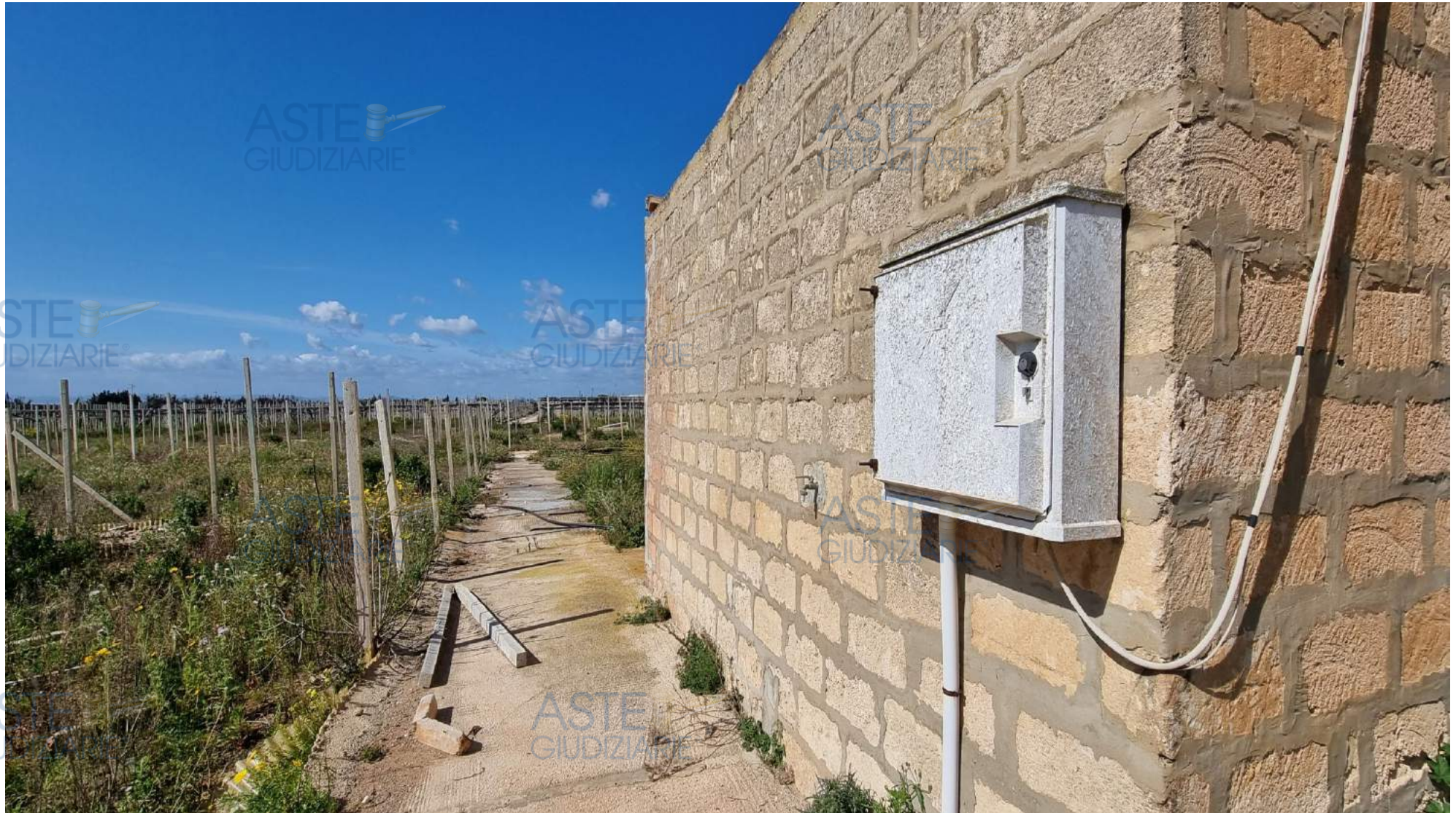
Foto n. 15 - Idem: prospetto laterale
