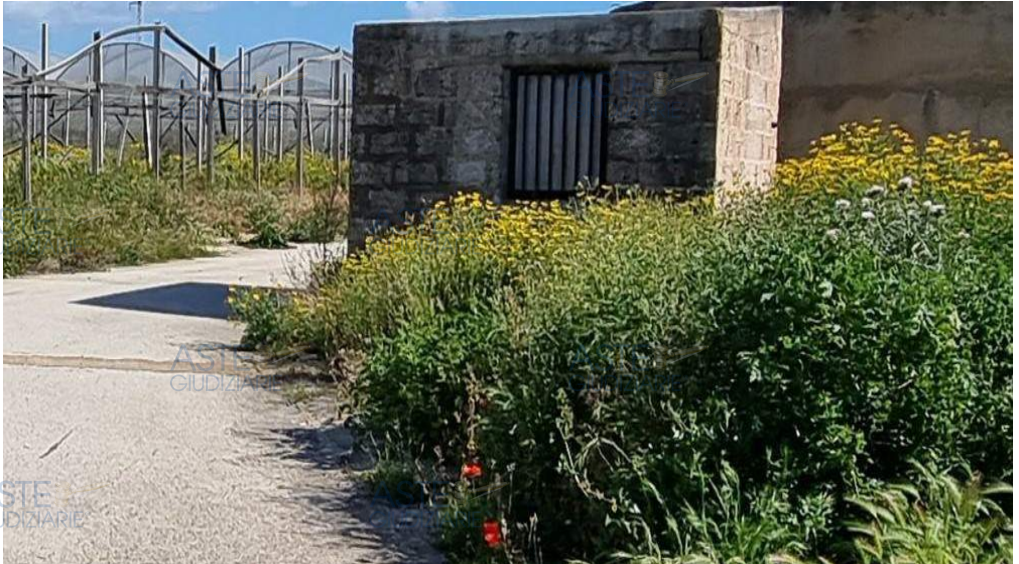
Foto n. 18 - Idem - Prospetto laterale
