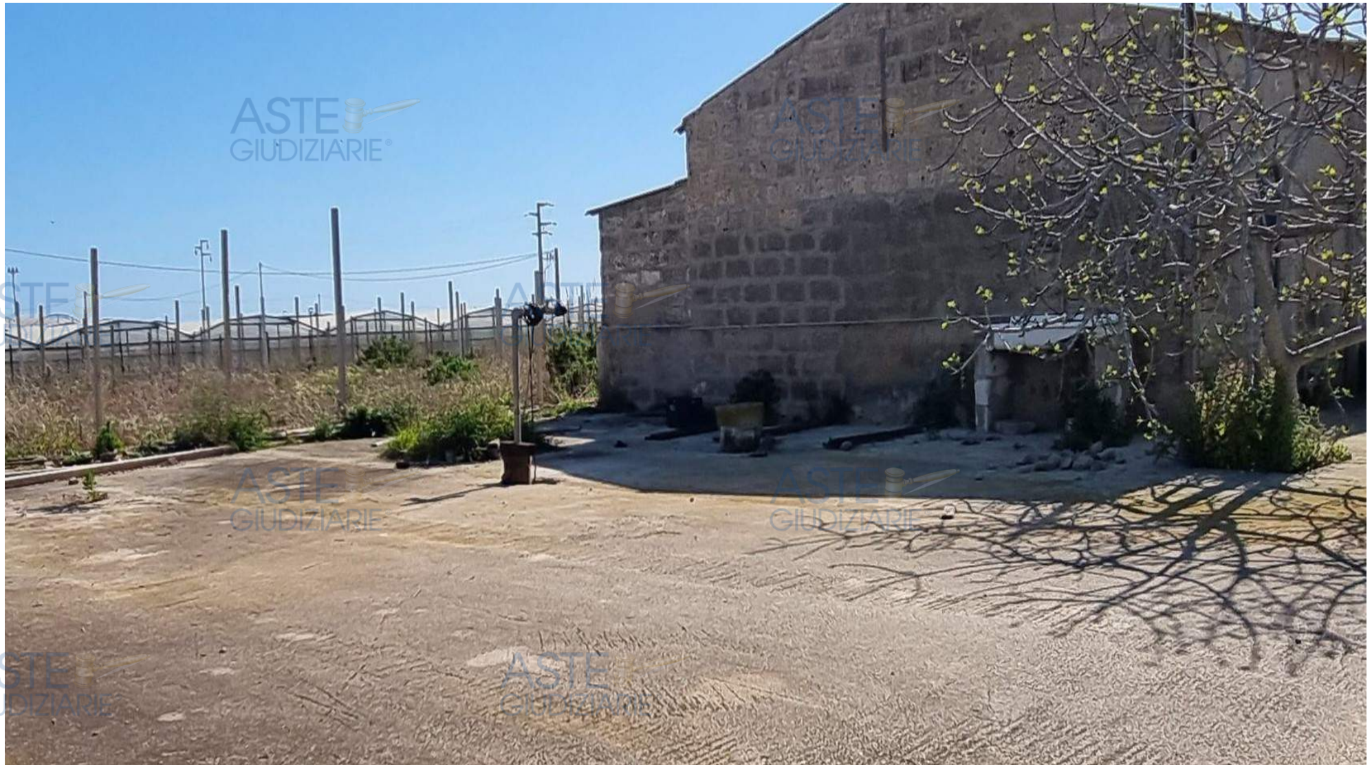
Foto n. 20 - Pozzo in prossimità del primo fabbricato (mappale 446/1)
