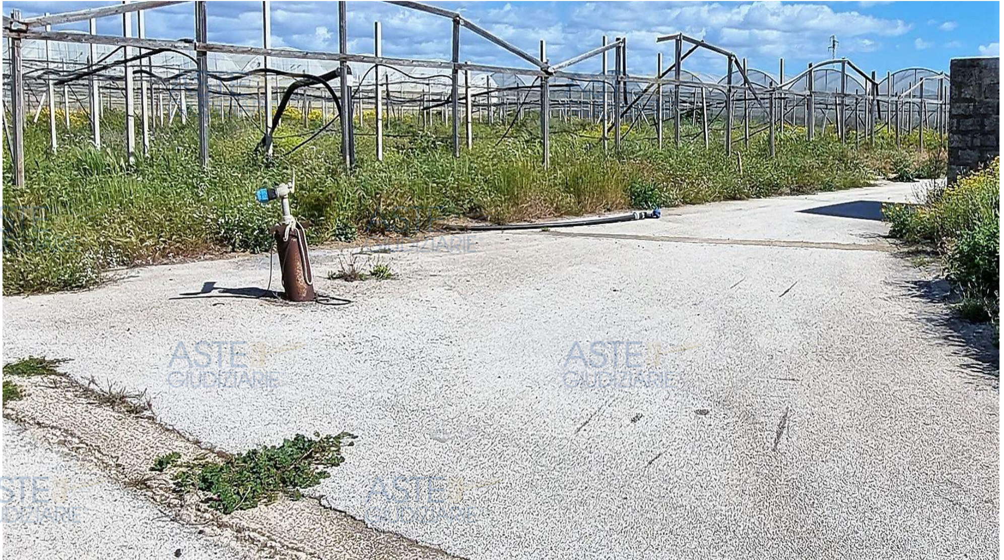
Foto n. 19 - Pozzo in prossimità della vasca di accumulo (a dx si vede lo spigolo del casotto non accatastato)
