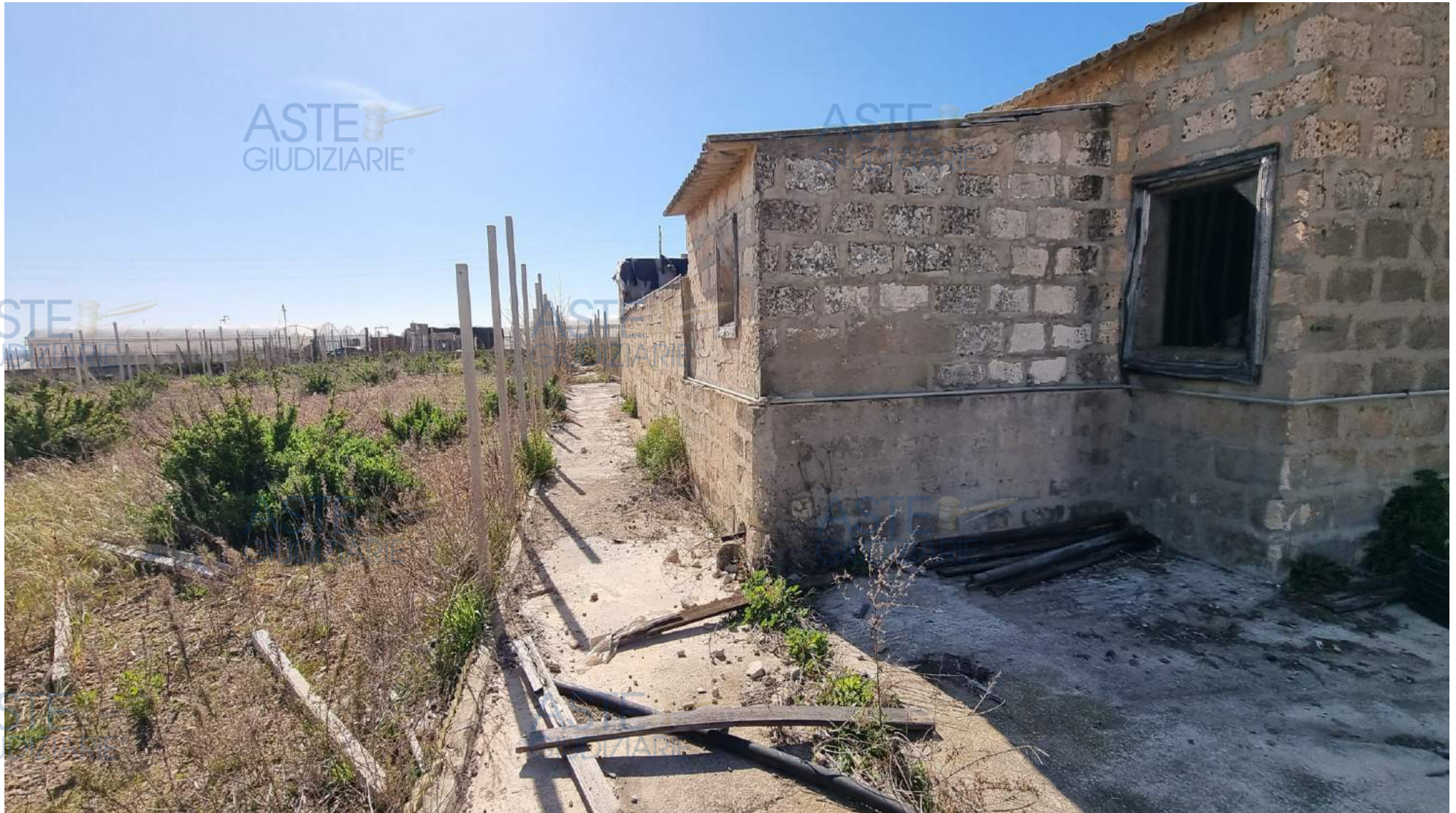
Foto n. 8 – Primo fabbricato (foglio 199/B - mappale 446, sub 1): retrospetto e porzione del prospetto a nord
