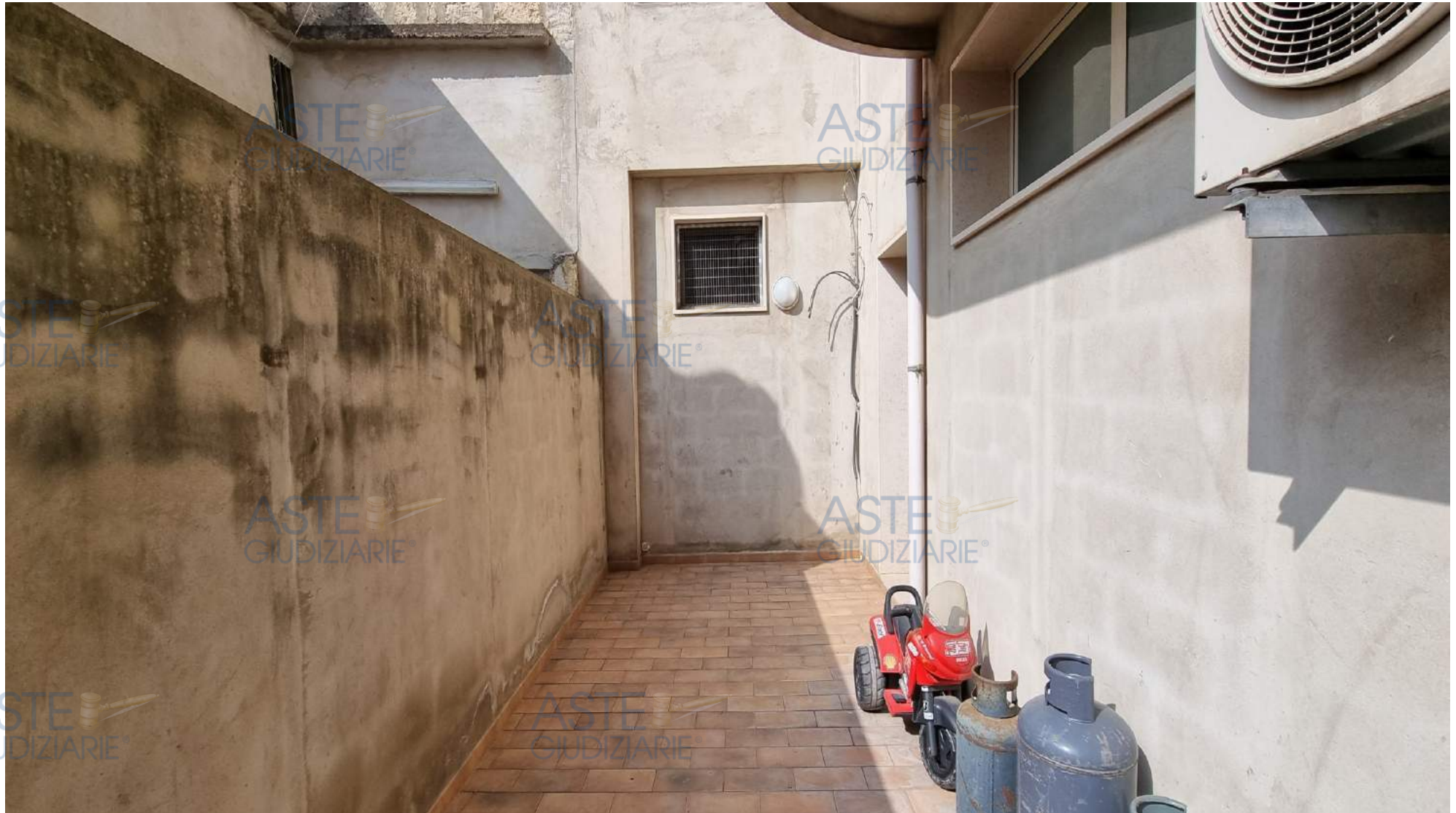
Foto n. 26 - Cavedio annesso al garage
