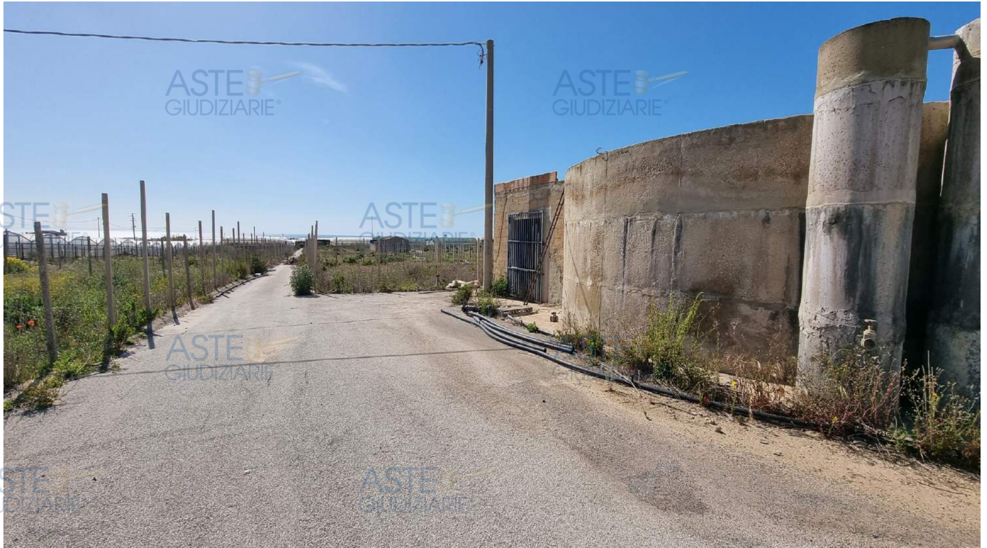
Foto n. 14 -Secondo fabbricato (foglio 199/B - mappale 450, sub1) - Vasca di raccolta e vano tecnico.
