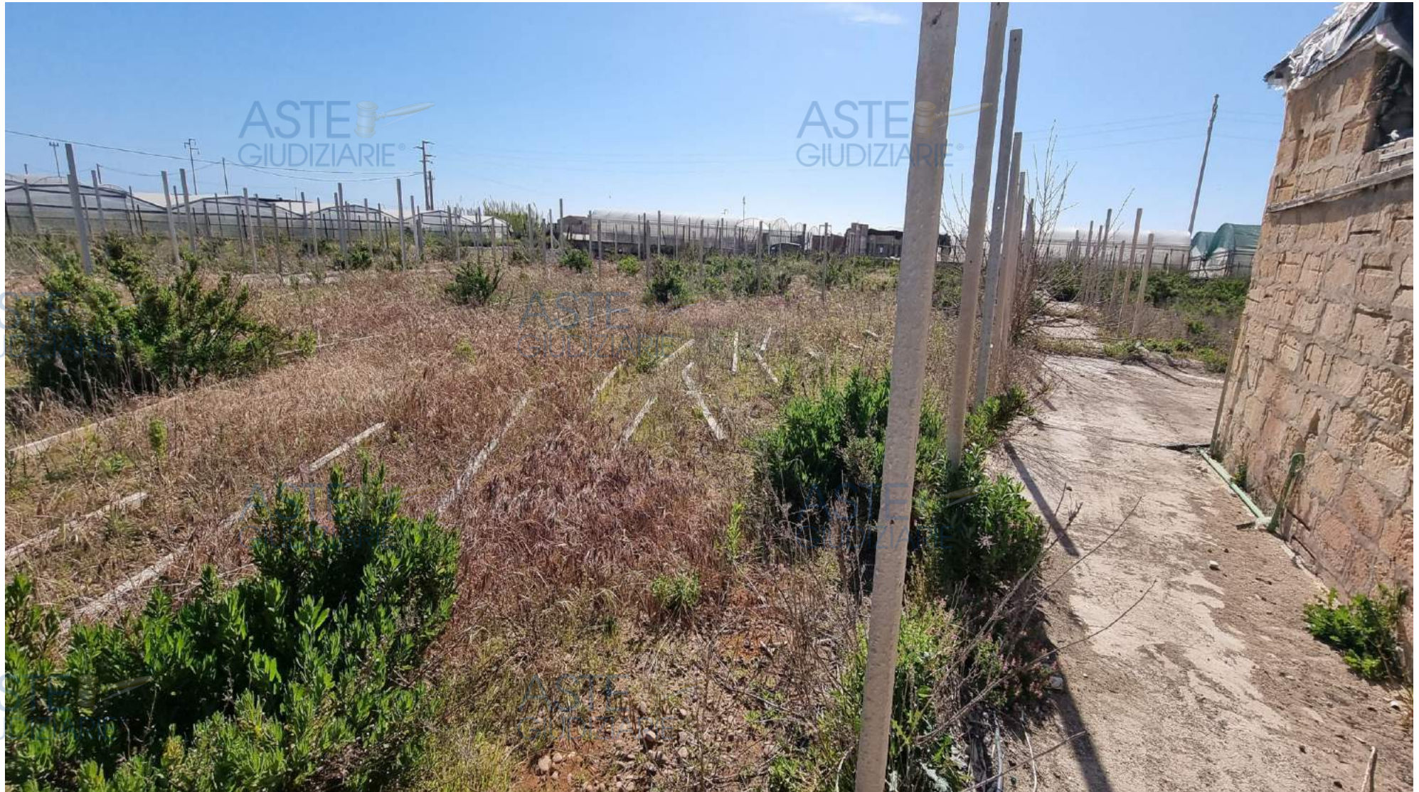
Foto n. 3 - Paletti in calcestruzzo prefabbricati
