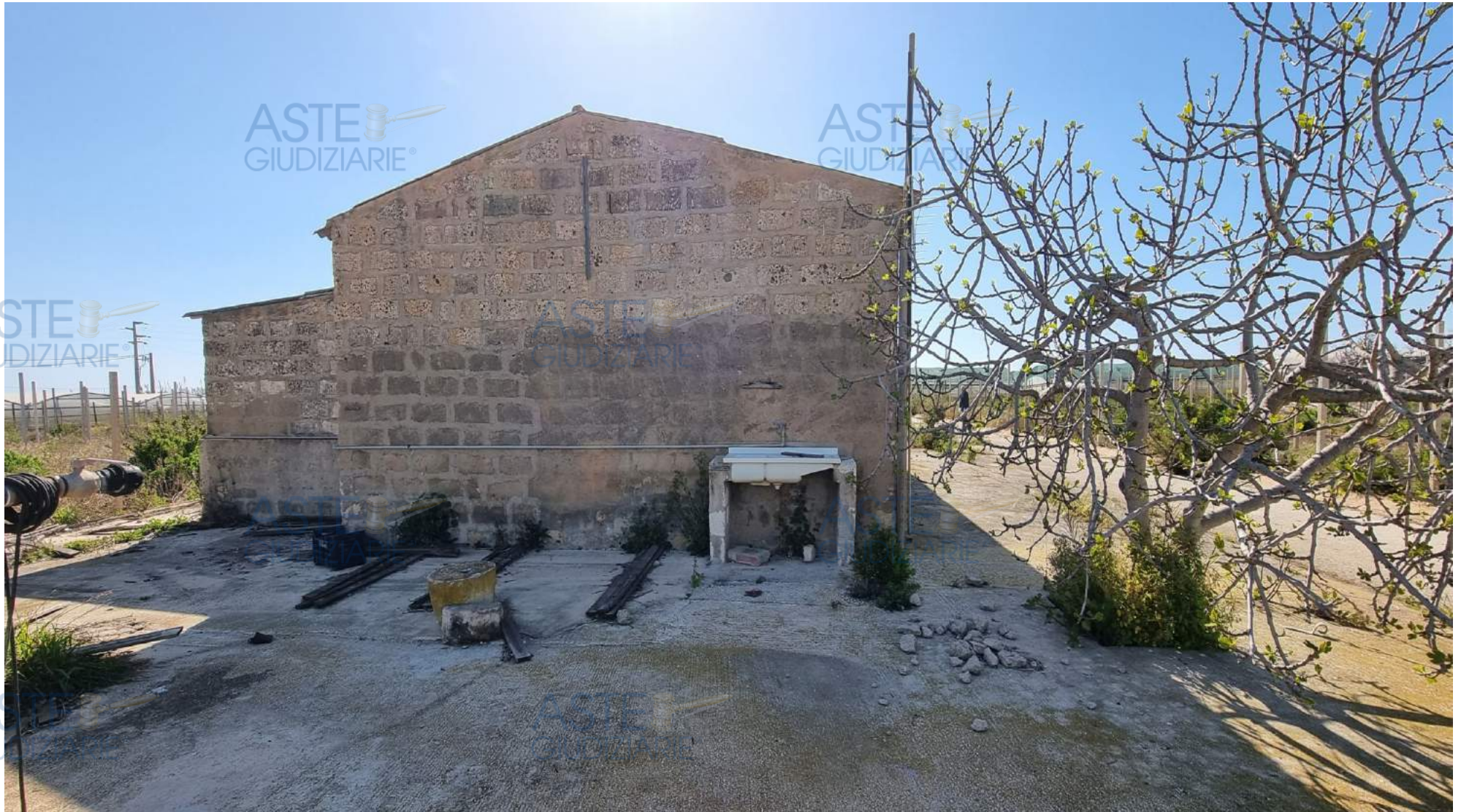
Foto n. 9 – Primo fabbricato (foglio 199/B - mappale 446, sub 1): prospetto a nord
