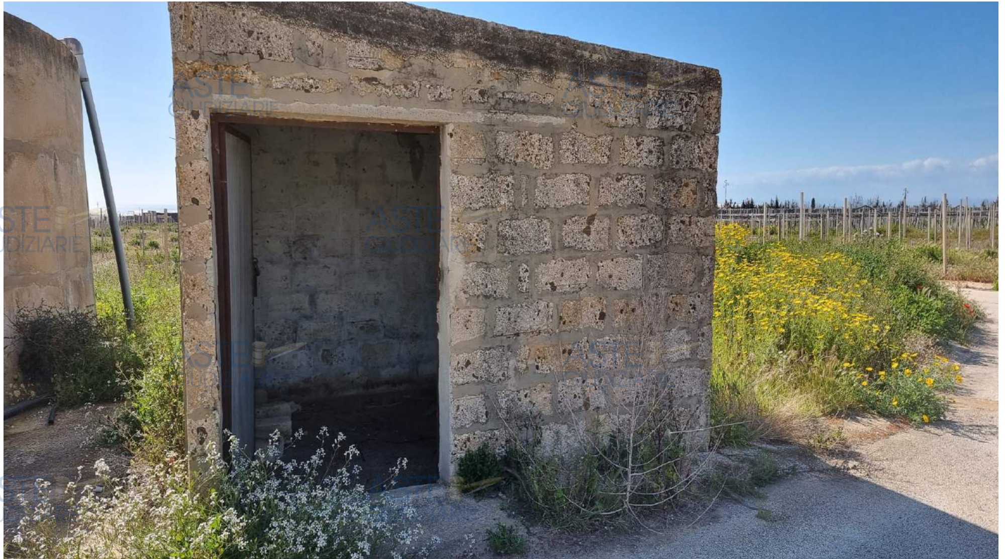
Foto n. 17 - Terzo fabbricato non accatastato - Prospetto principale
