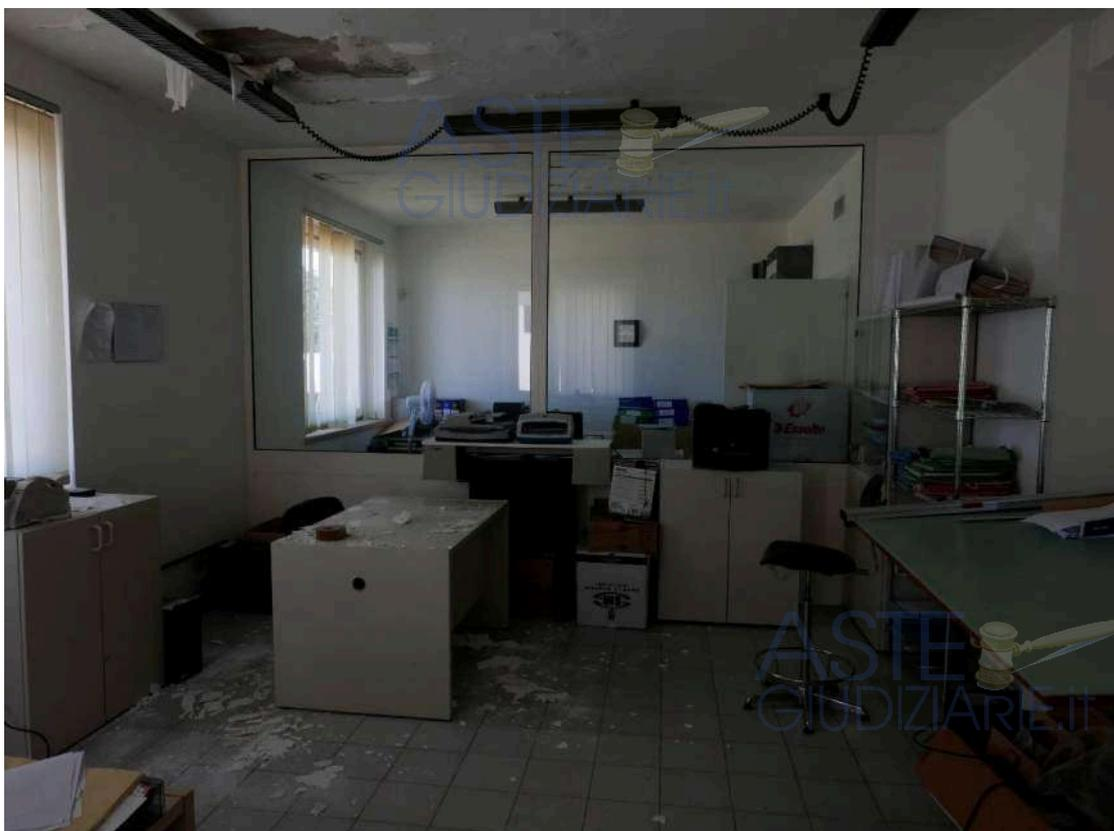
18. Interno del corpo uffici, si notano sul soffitto infiltrazioni provenienti dal solaio di copertura.
