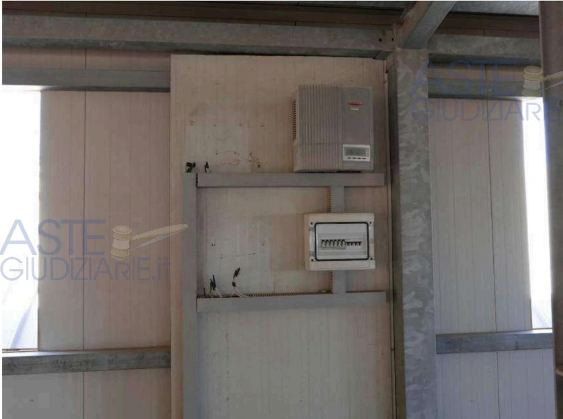
33. Dettaglio della posizione degli inverter dell'impianto fotovoltaico in parte asportati.
