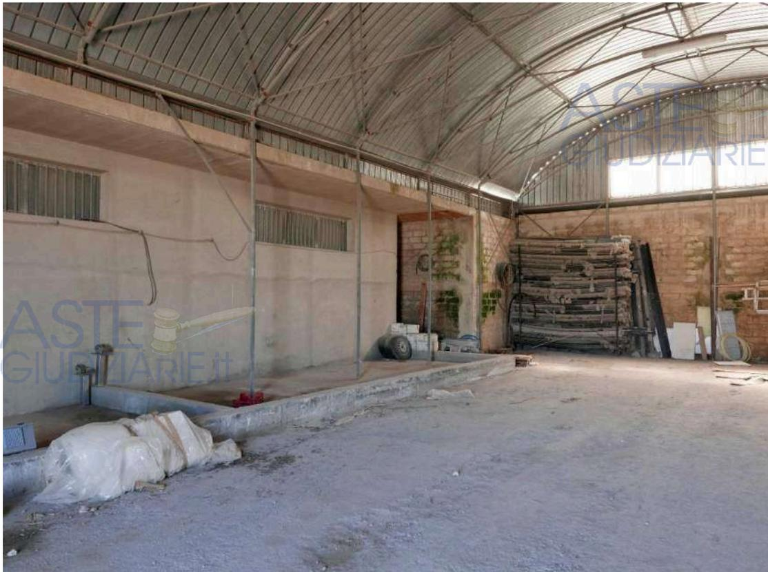
7. L'interno di una delle tettoie. Si tratta di quella attigua al corpo magazzino visibile a sinistra nella foto. Si nota la struttura di sostegno della tettoia costituita da esili tubolari in acciaio. La tettoia poggia in parte sulla struttura del magazzino, posteriormente sul muro di contenimento del terrapieno.
