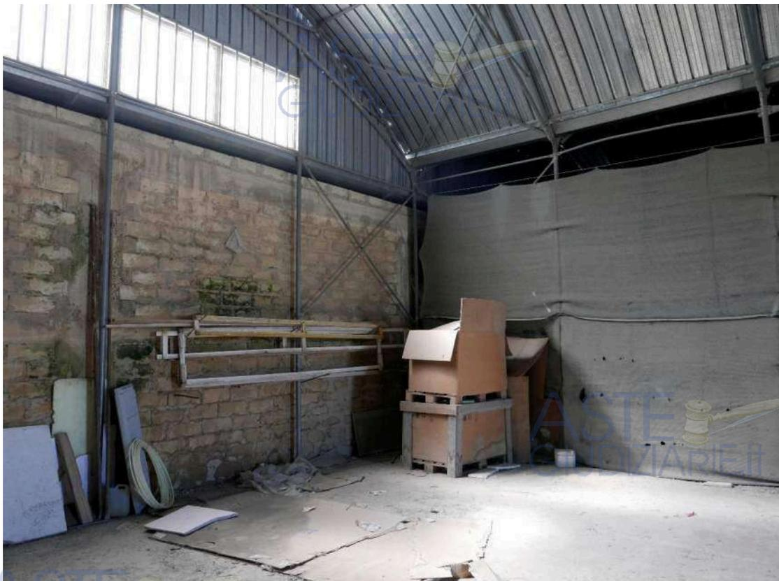
8. Interno di una delle tettoie. Si nota il muro di contenimento del terrapieno su cui poggia la tettoia.
