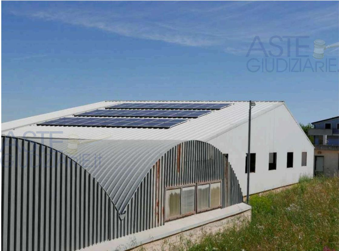
29. Vista dell'impianto fotovoltaico installato su una delle falde della struttura soprastante il magazzino.
