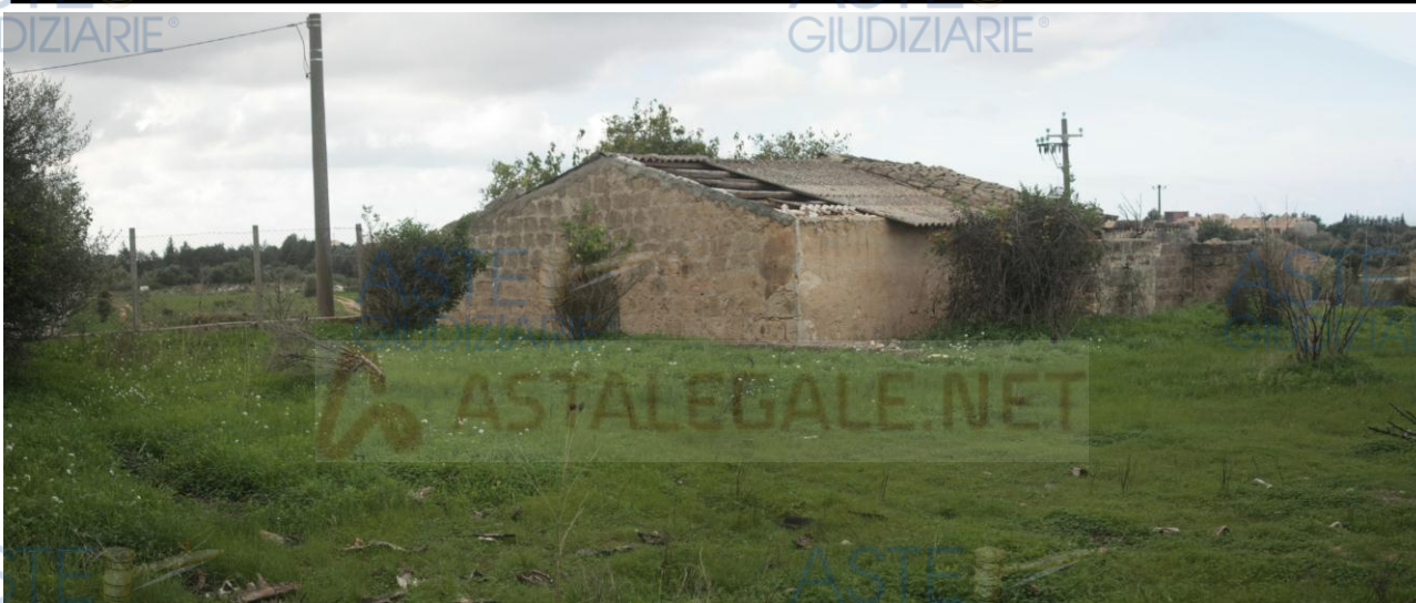
Cespite 2: Fabbricato rurale visto da dietro lato destro
