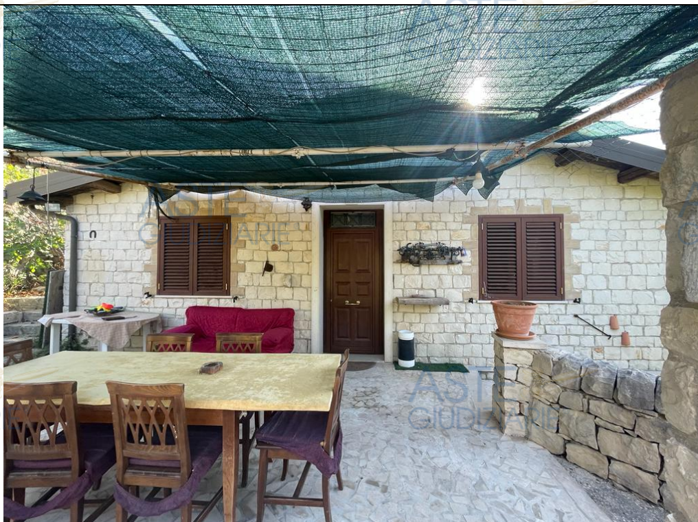
Prospetto principale - ovest
