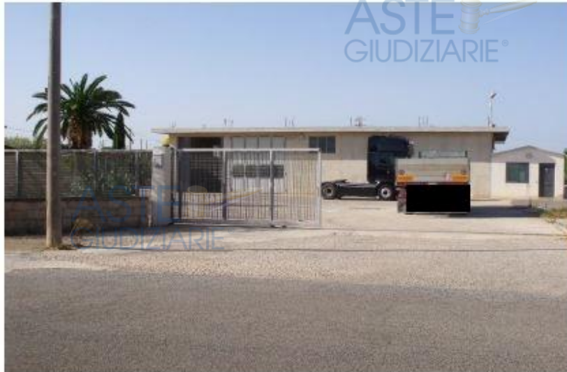
ESTERNO - INGRESSO DALLA STRADA COMUNALE
