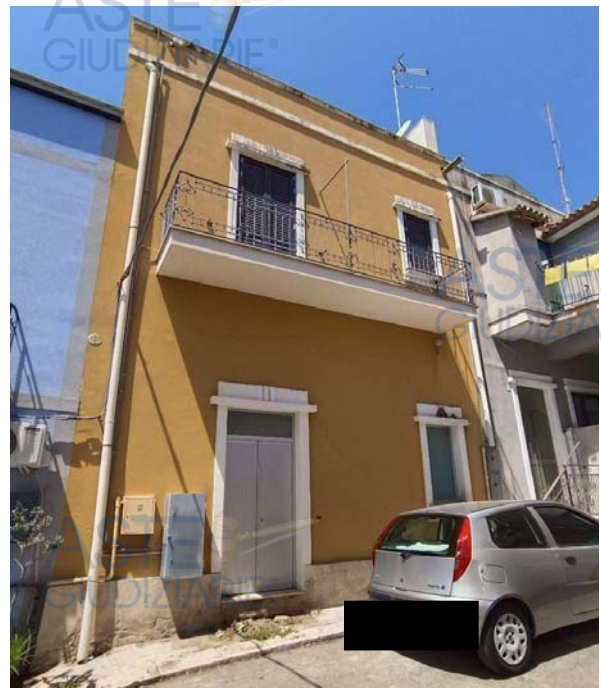
Retroprospetto su ronco della via Crispi
