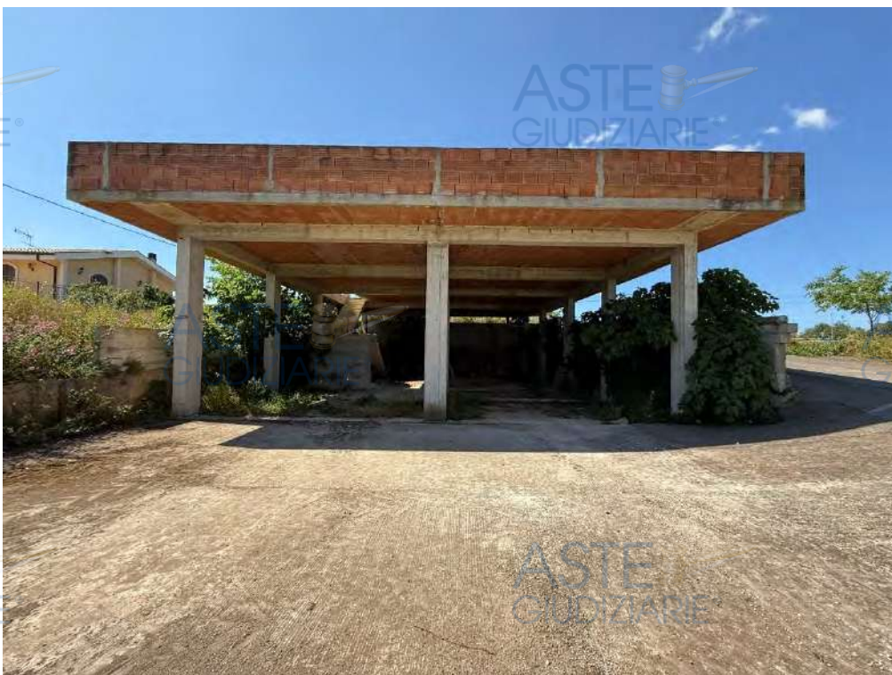
Vista esterno (locale deposito)
