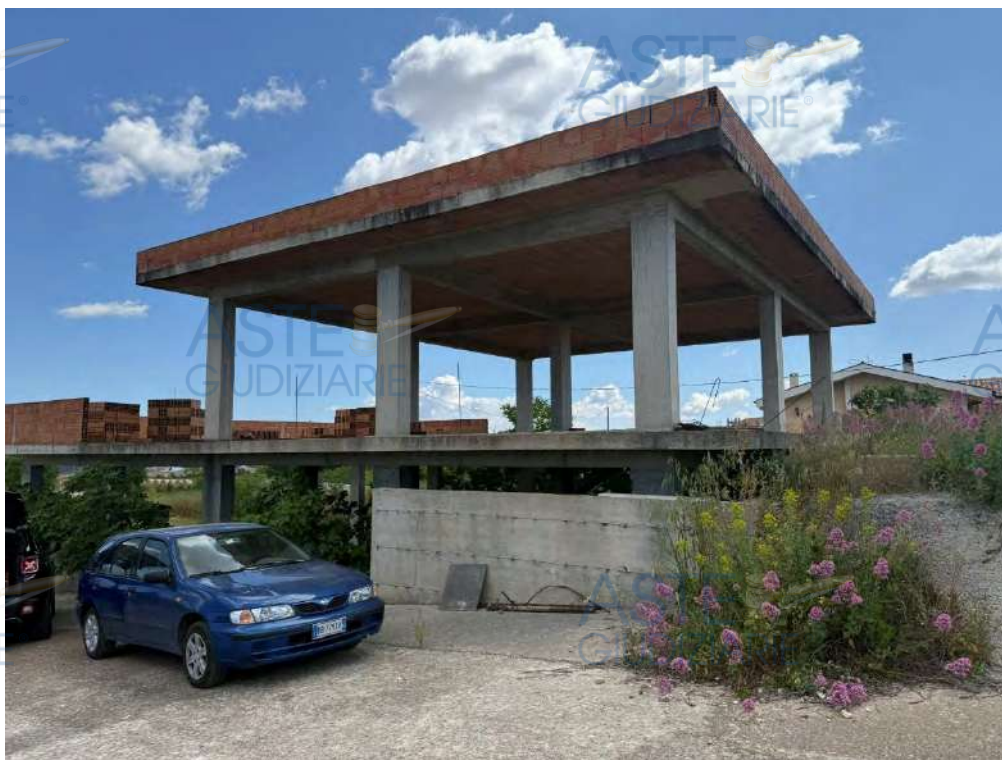
Vista esterno (locale deposito)
