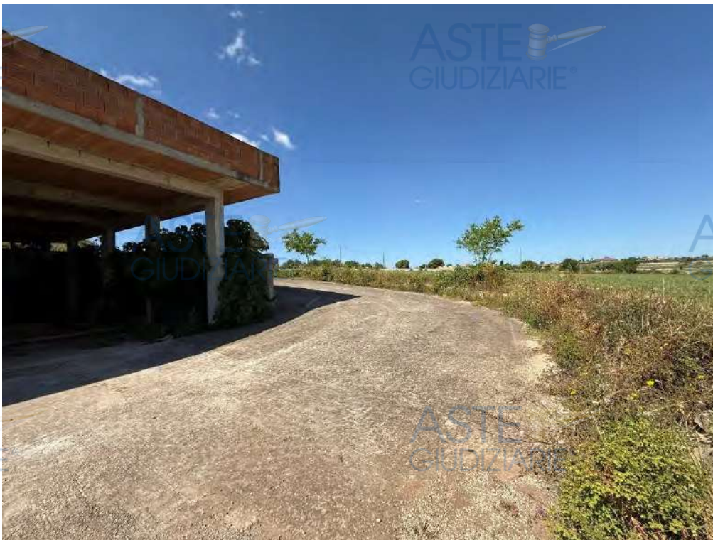
Vista esterno (rampa di accesso al locale deposito)
