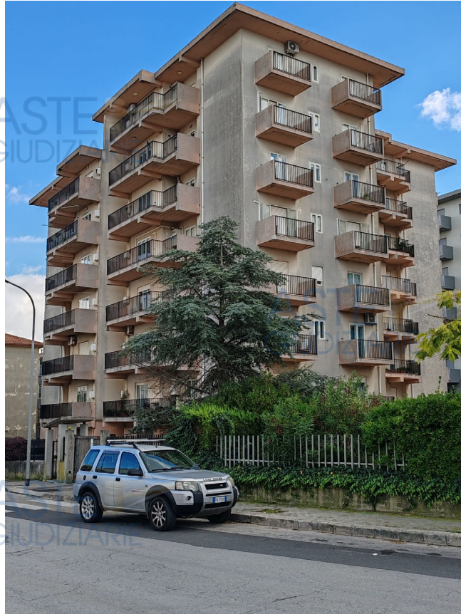
Foto n.1 – Prospetto su via Psaumida.
