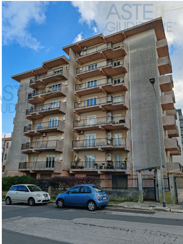
Foto n.2 – Prospetto su via Psaumida.
