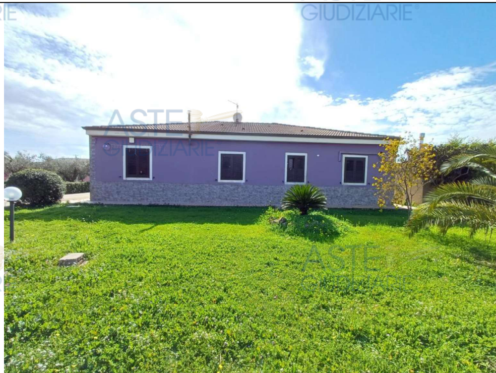
Foto n.4 Retro prospetto – Lato strada
