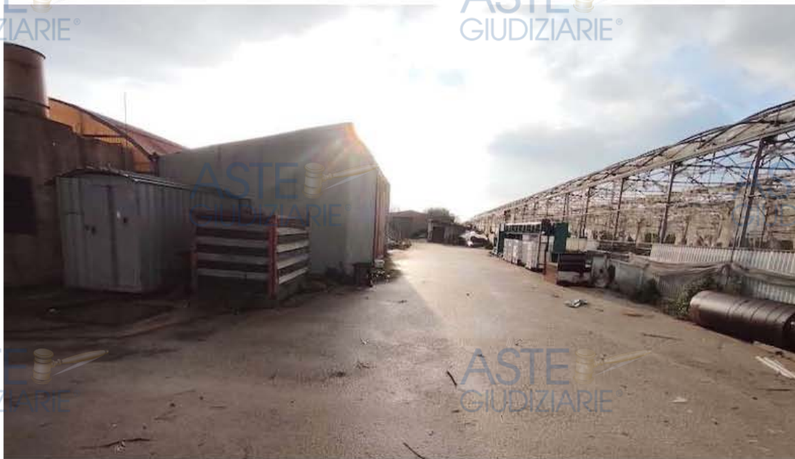
Foto 38 – Lotto 2 – Accesso esterno alla serra 2 e locale tecnico E
