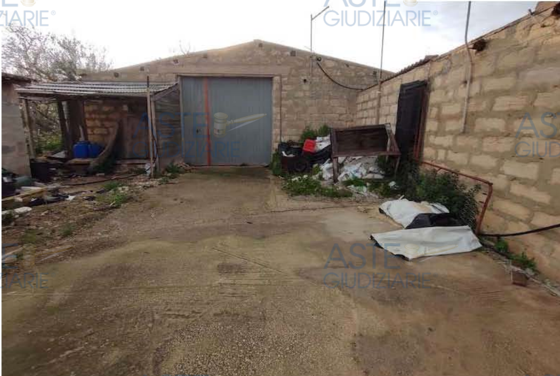
Foto 48 – Lotto 2 – Deposito cat. D10 particella 832 sub 1
