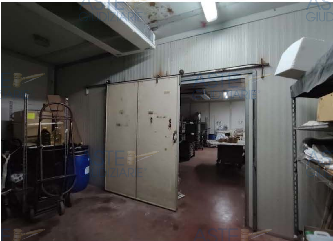
Foto 23 – Lotto 2 – Interno cella frigo A
