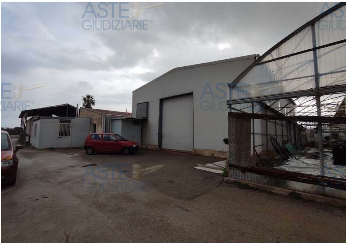
Foto 4 – Lotto 2 – Capannone deposito cat. D10 particella 531 sub 1
