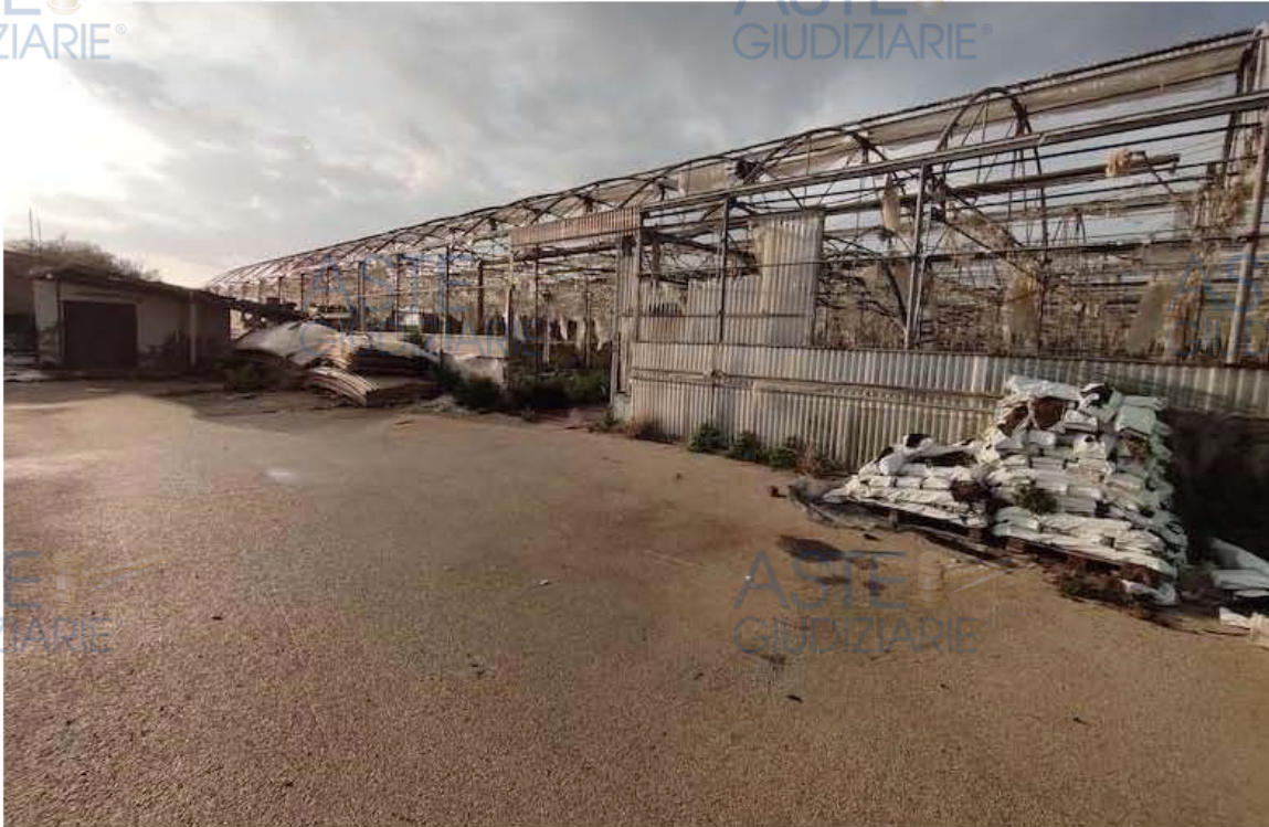
Foto 60 – Lotto 2 – Accesso esterno alla serra 2
