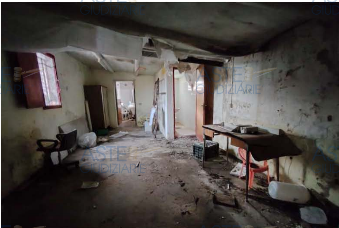
Foto 58 – Lotto 2 – Interno deposito cat. D10 particella 832 sub 1
