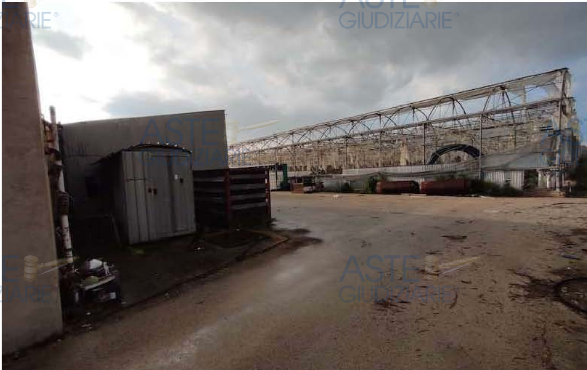
Foto 36 – Lotto 2 – Accesso esterno alla serra 2 e locale tecnico E
