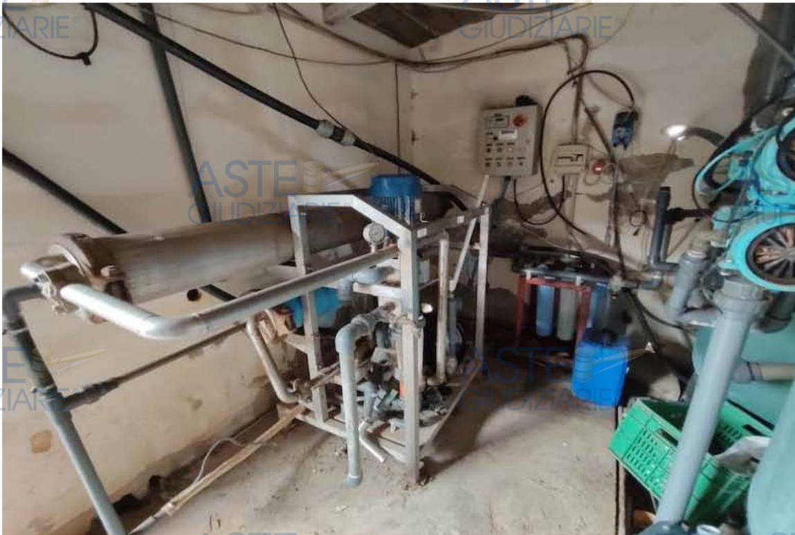
Foto 44 – Lotto 2 – Interno locale tecnico cat. D10 particella 832 sub 1
