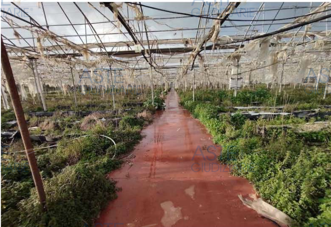
Foto 62 – Lotto 2 – Interno serra 2 in stato di abbandono
