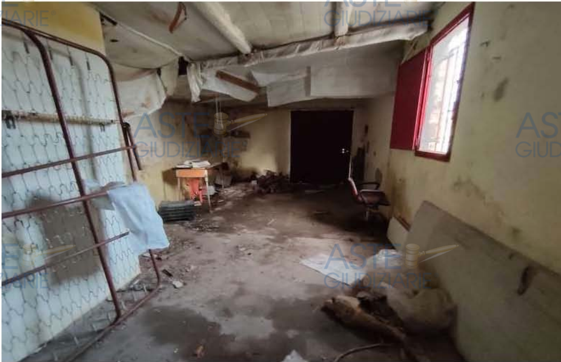
Foto 57 – Lotto 2 – Interno deposito cat. D10 particella 832 sub 1
