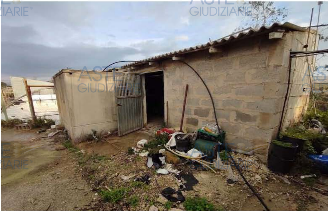
Foto 42 – Lotto 2 – Cisterna fuori terra e locale tecnico cat. D10 particella 832 sub 1
