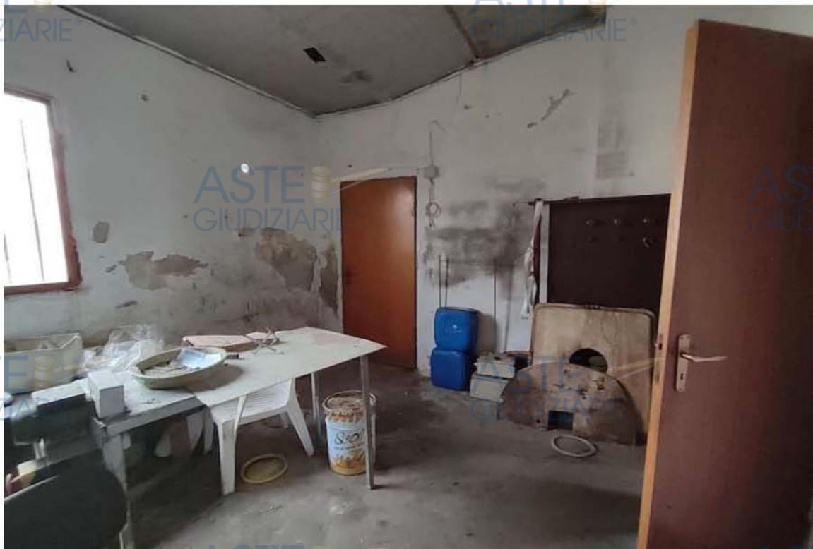
Foto 54 – Lotto 2 – Interno deposito cat. D10 particella 832 sub 1
