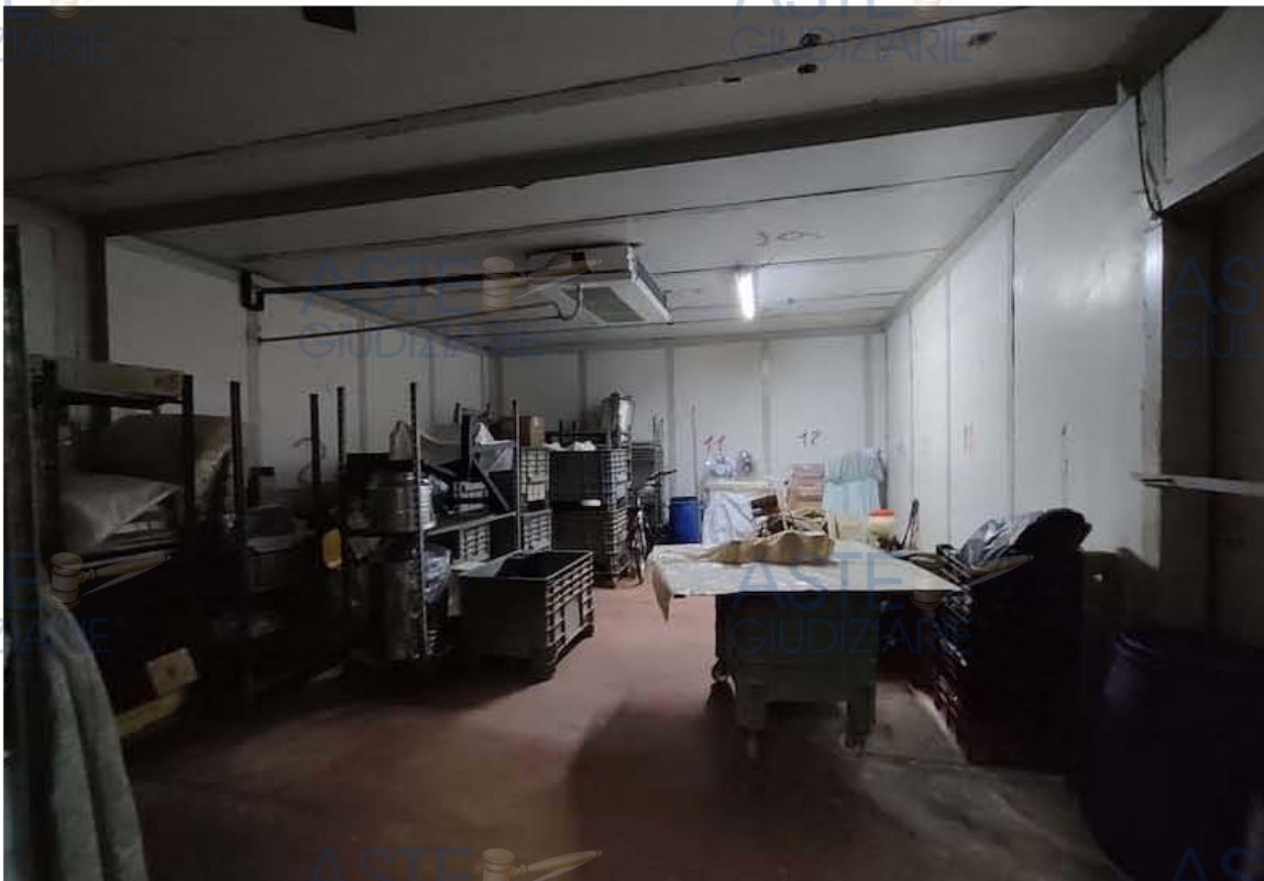
Foto 24 – Lotto 2 – Interno cella frigo A
