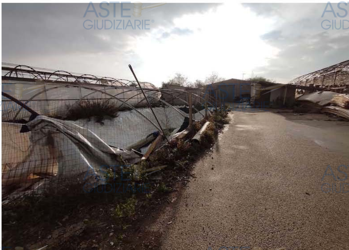
Foto 39 – Lotto 2 – Accesso esterno alla serra 2 ed invaso raccolta acqua
