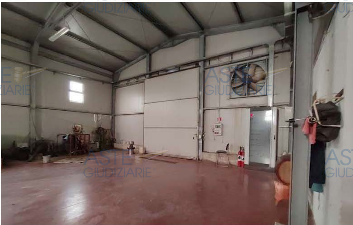
Foto 6 – Lotto 2 – Vista interna del capannone deposito cat. D10 particella 531 sub 1
