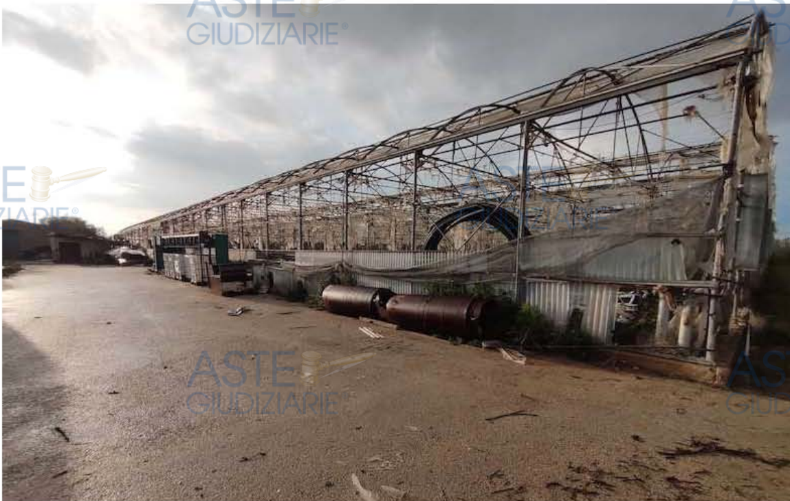
Foto 37 – Lotto 2 – Accesso esterno alla serra 2
