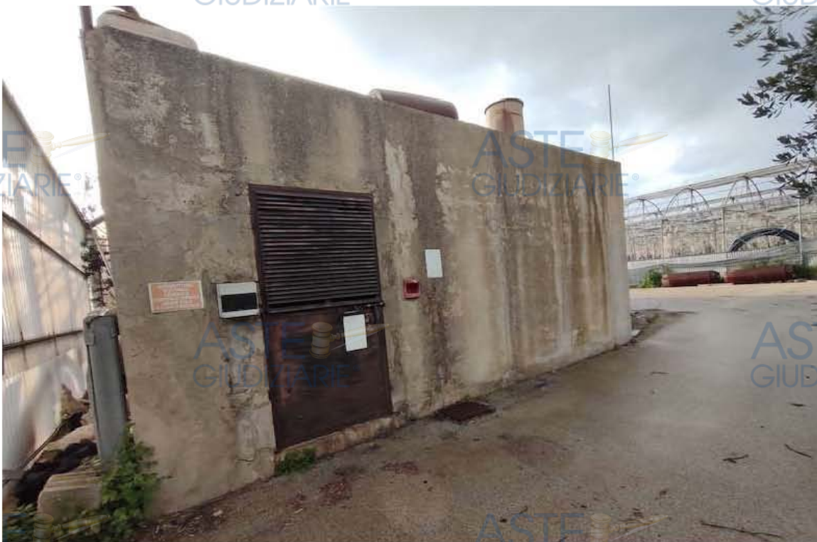
Foto 33 – Lotto 2 – Locale caldaia C privo di regolarità edilizia e catastale – vista esterna
