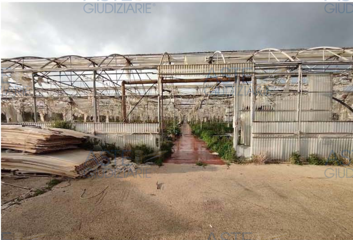
Foto 61 – Lotto 2 – Accesso esterno alla serra 2
