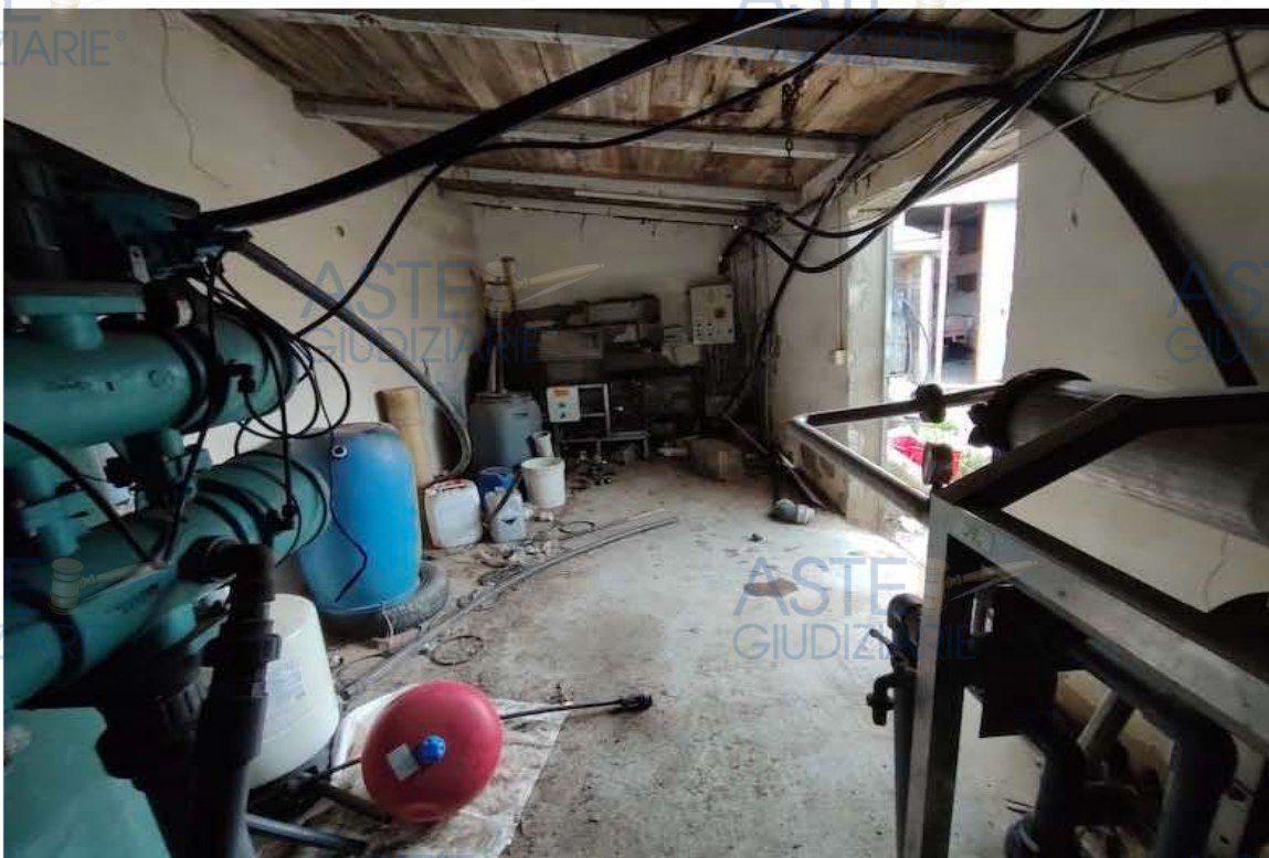
Foto 46 – Lotto 2 – Interno locale tecnico cat. D10 particella 832 sub 1
