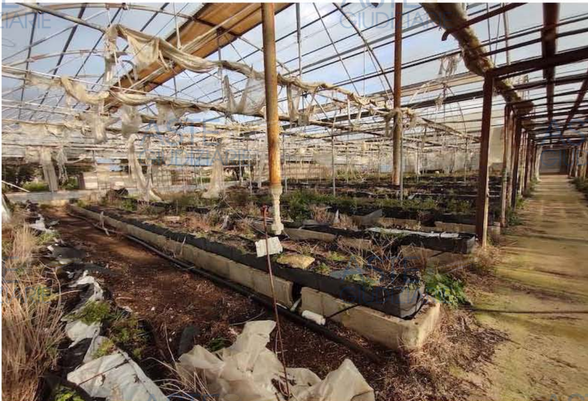
Foto 32 – Lotto 2 – Interno serra 1 in stato di abbandono
