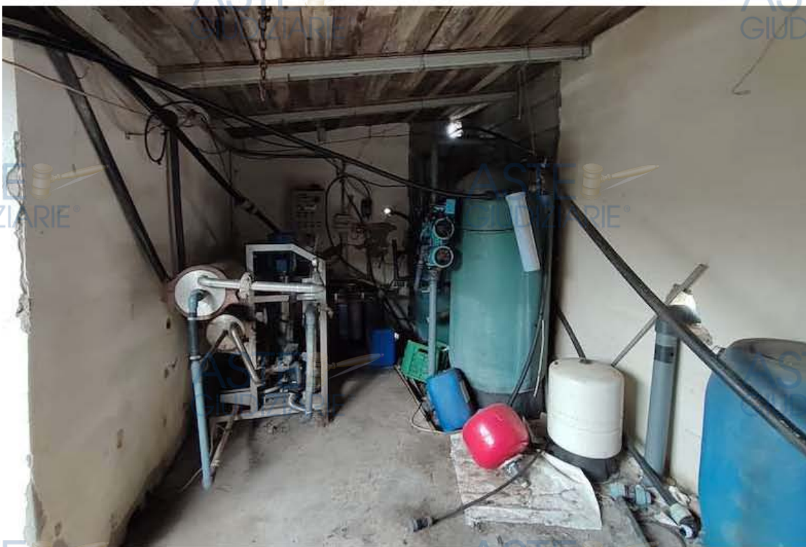
Foto 43 – Lotto 2 – Interno locale tecnico cat. D10 particella 832 sub 1
