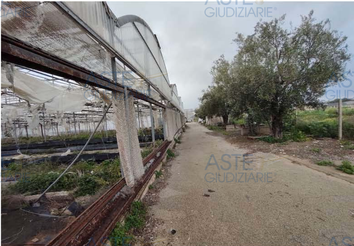
Foto 28 – Lotto 2 – Accesso esterno alla serra 1
