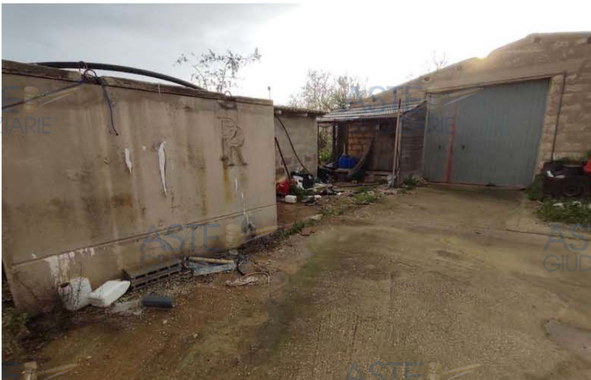
Foto 41 – Lotto 2 – Cisterna fuori terra e deposito cat. D10 particella 832 sub 1
