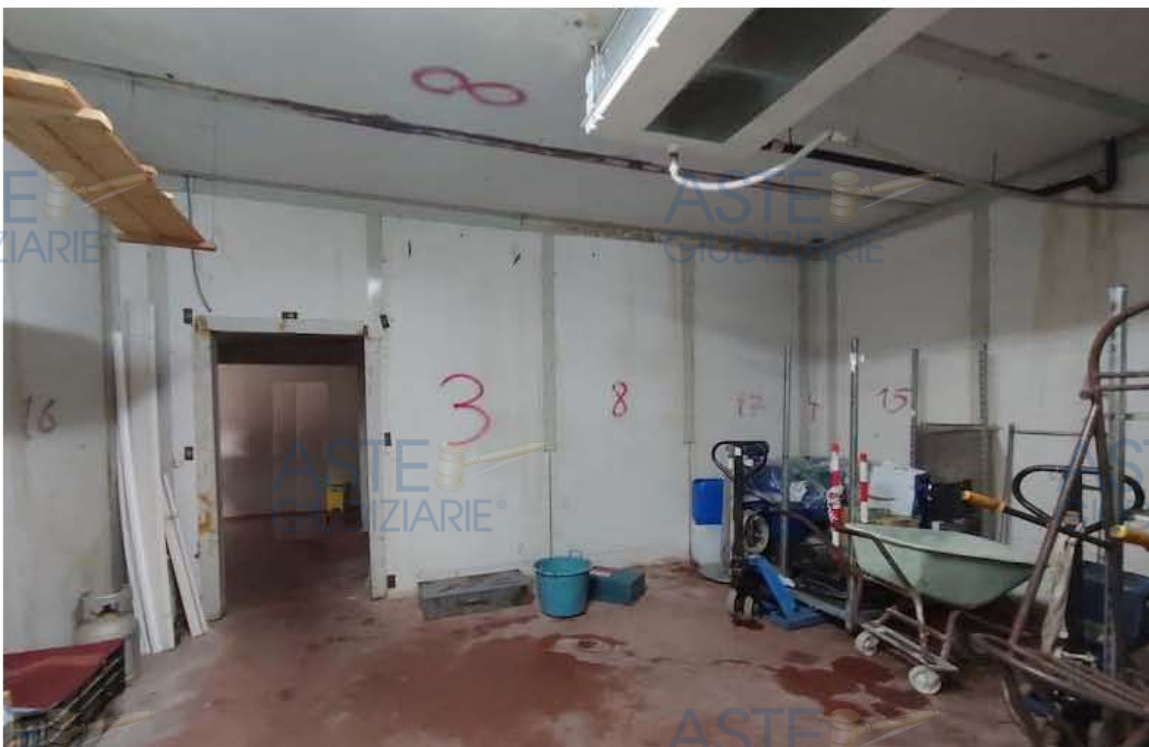
Foto 25 – Lotto 2 – Interno cella frigo A
