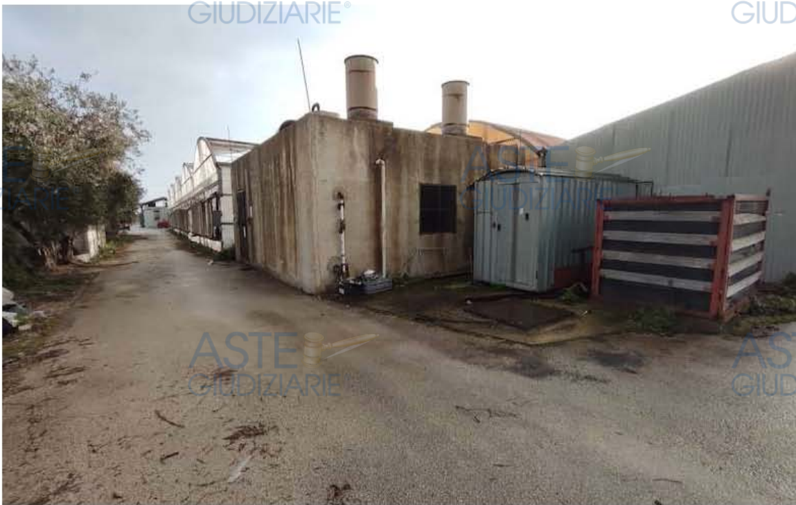
Foto 35 – Lotto 2 – Accesso esterno alla serra 1 e locale caldaia C
