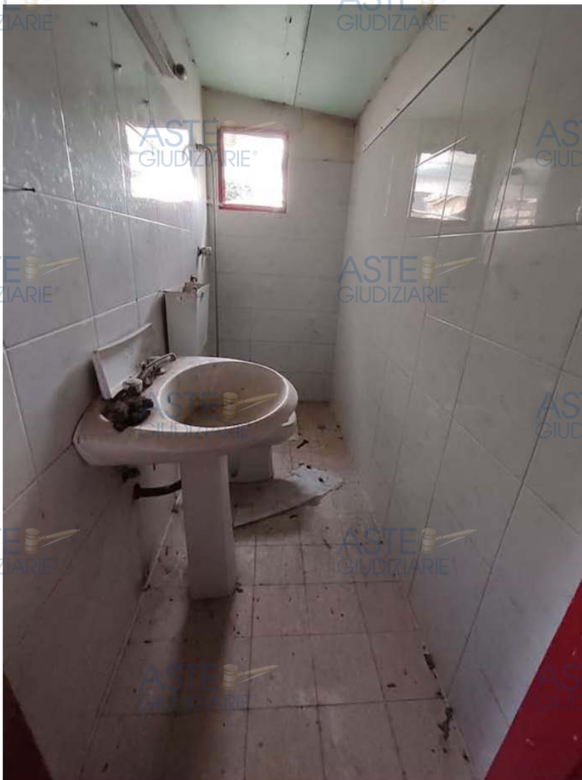
Foto 59 – Lotto 2 – Bagno deposito cat. D10 particella 832 sub 1
