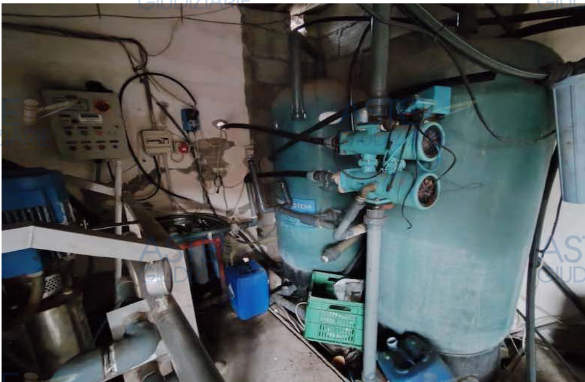
Foto 45 – Lotto 2 – Interno locale tecnico cat. D10 particella 832 sub 1
