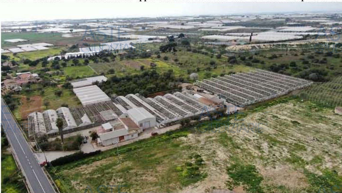
Foto 2 – Lotto 2 – Vista aerea dell'appezzamento adiacente alla Discarica comprensoriale
