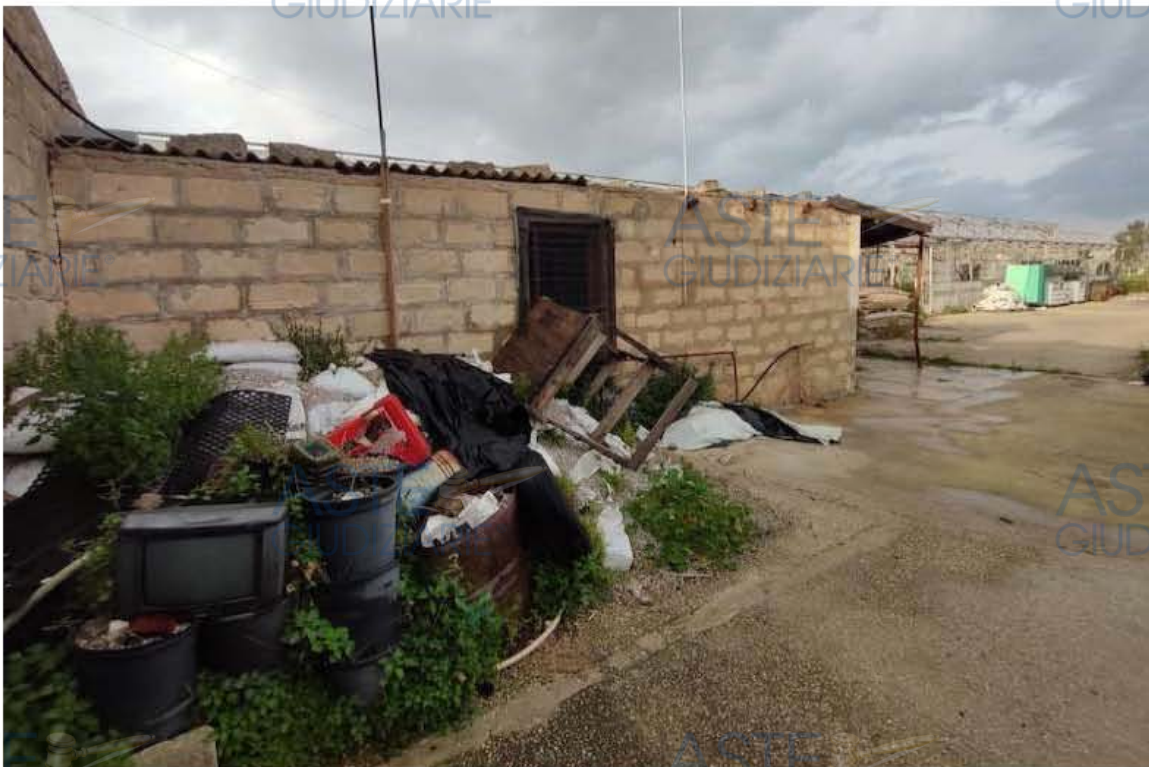
Foto 49 – Lotto 2 – Deposito cat. D10 particella 832 sub 1
