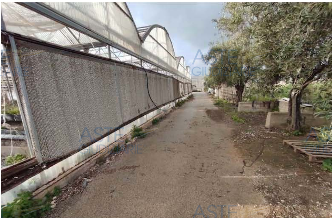
Foto 29 – Lotto 2 – Accesso esterno alla serra 1
