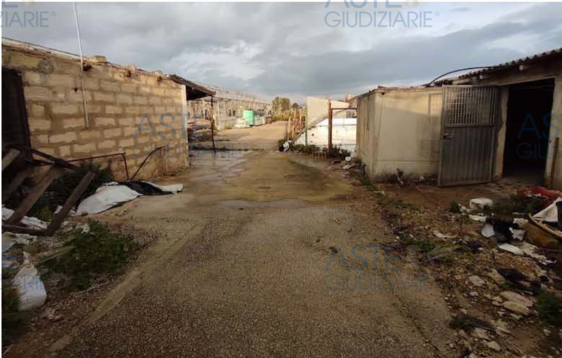
Foto 50 – Lotto 2 – Deposito cat. D10 particella 832 sub 1
