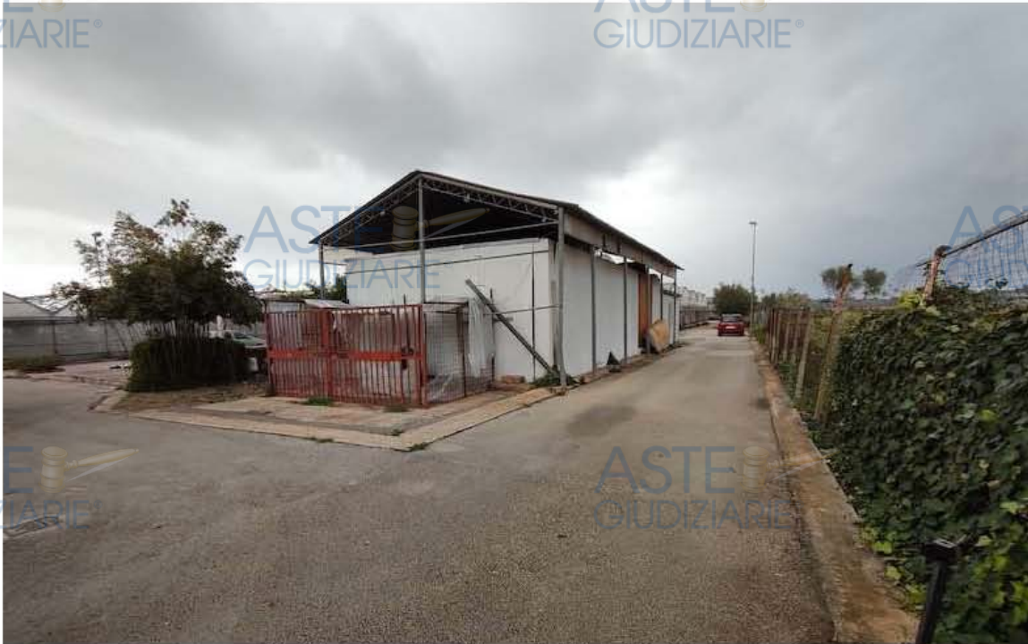
Foto 22 – Lotto 2 – Cella frigo A priva di regolarità edilizia e catastale – vista esterna
