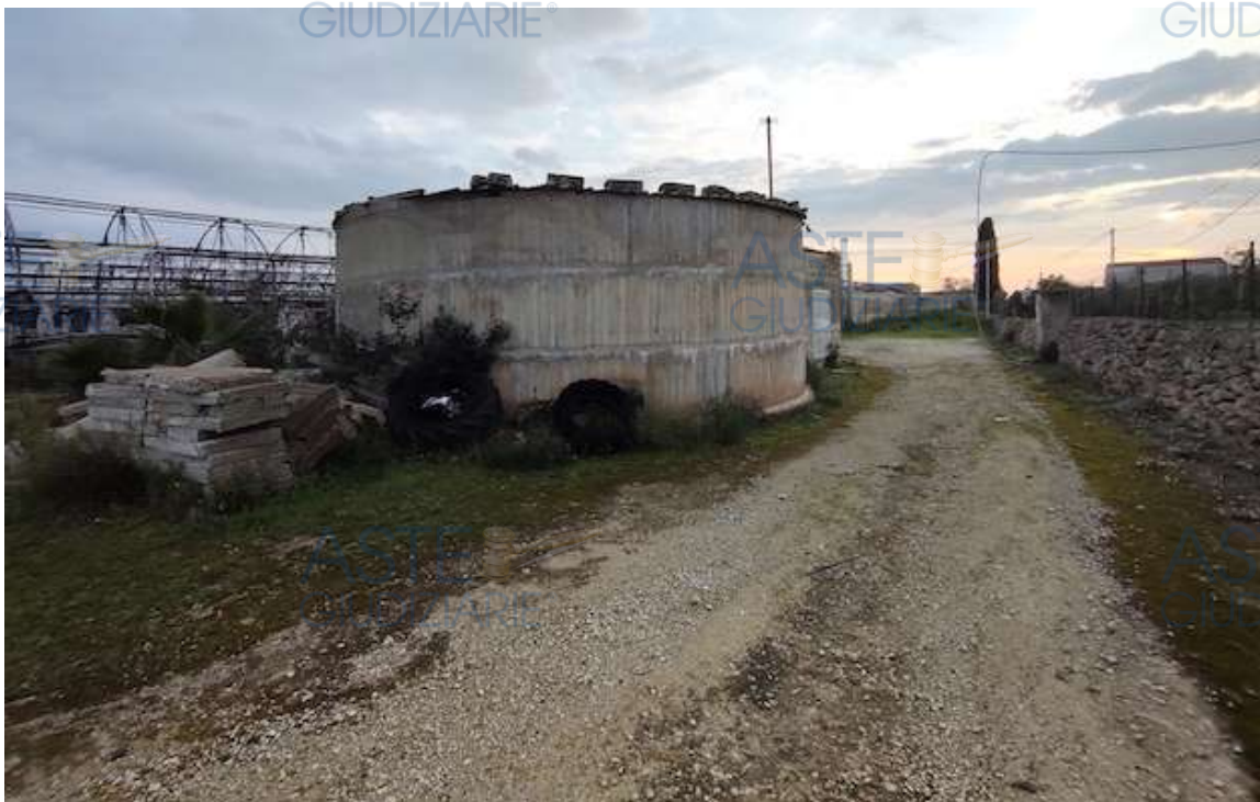
Foto 8 – Lotto 3 – Vasca fuori terra
