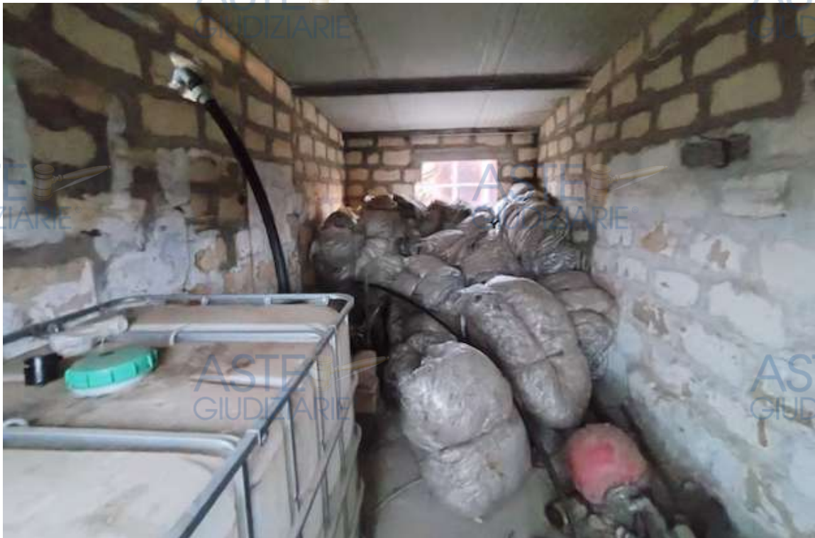
Foto 10 – Lotto – Interno casotto deposito
