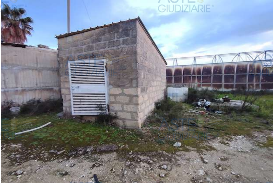
Foto 11 – Lotto 3 – Vasca fuori terra, casotto deposito e pozzo trivellato
