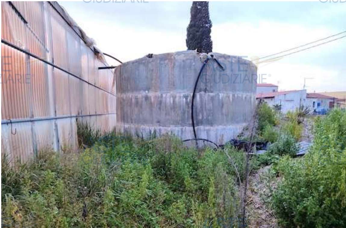
Foto 14 – Lotto 3 – Vasca fuori terra
