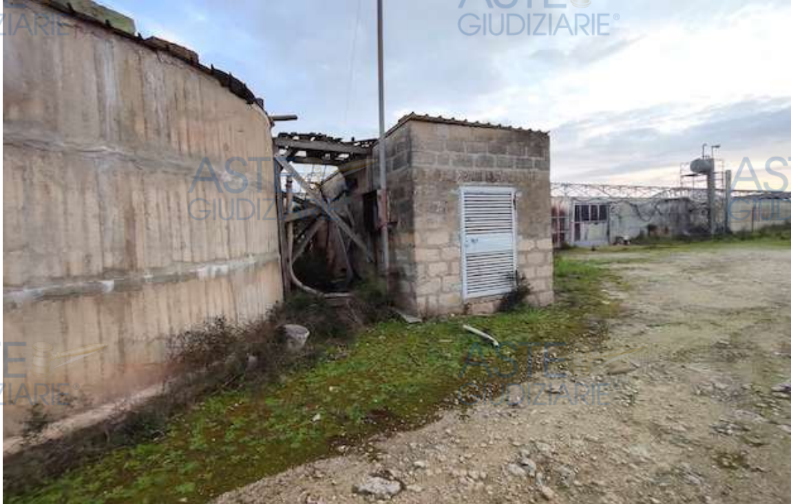
Foto 9 – Lotto 3 – Vasca fuori terra e casotto deposito
