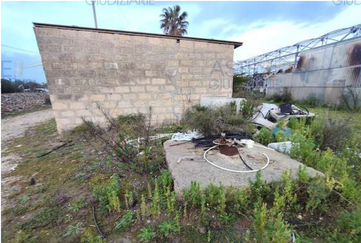
Foto 12 – Lotto 3 – Casotto deposito e pozzo trivellato
