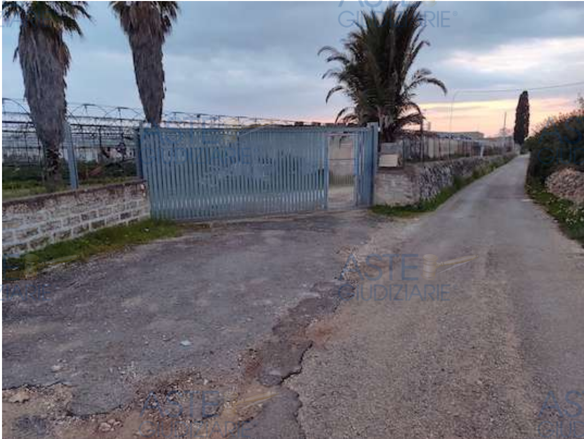
Foto 3 – Lotto 3 – Accesso dalla strada interpoderale
