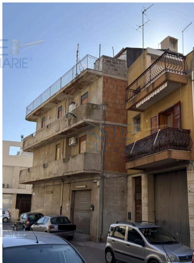
Figura n. 08 : Foto Prospetto su Via G. Scibilia.
