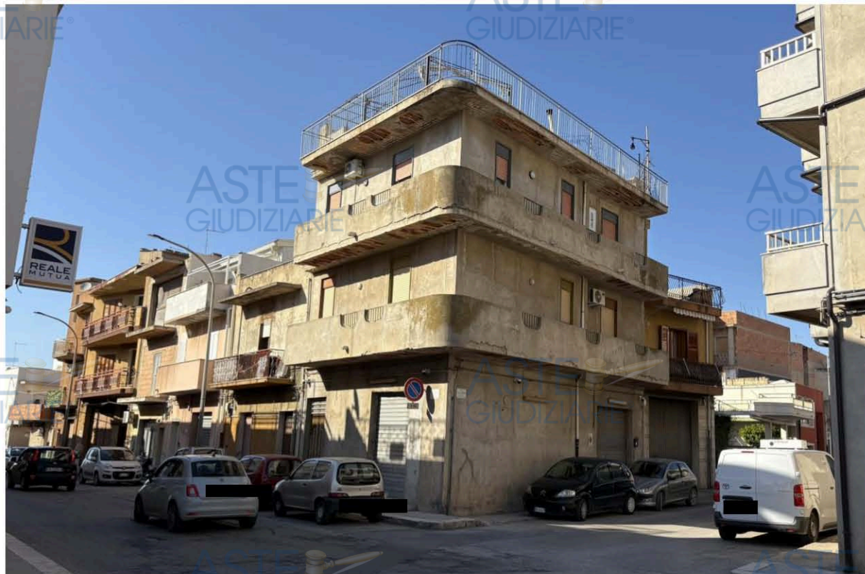
Figura n. 07 : Foto Prospetto Principale su Via Pietro Gentile angolo Via Giovanni Scibilia.
