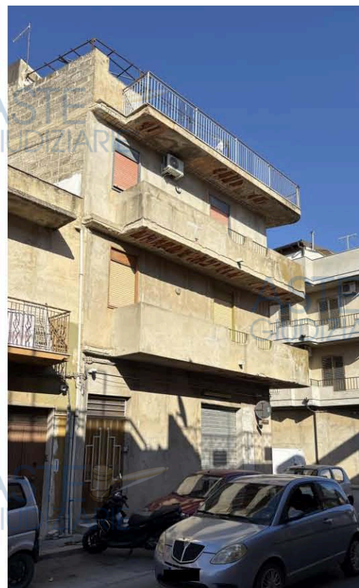
Figura n. 09 : Foto Prospetto su Via P. Gentile.
