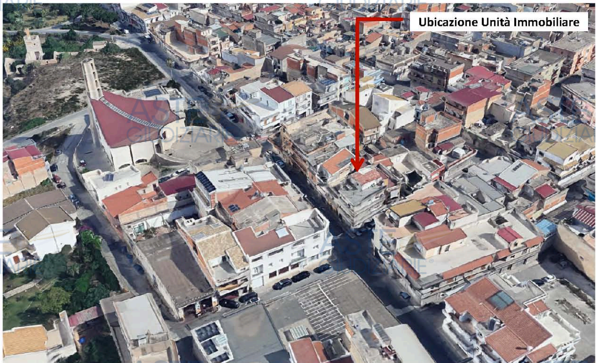
Figura n. 05 : Foto satellitare dell'unità immobiliare oggetto di stima
