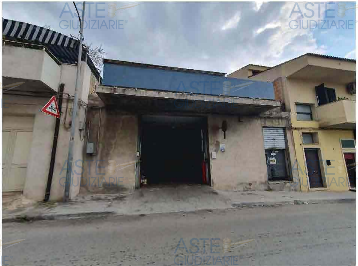
Prospetto su via Manzoni
