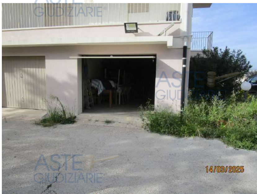
Foto n.2.2 - vista da via delle Mimose
