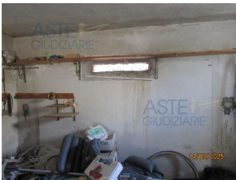
Foto n.2.6 – feritoia sulla parete di via dei Gelsomini (accesso murato)
