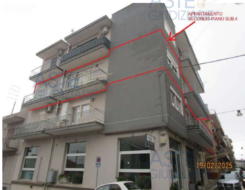
Foto n.1.2 - vista angolo via degli oleandri – via dei frassini
