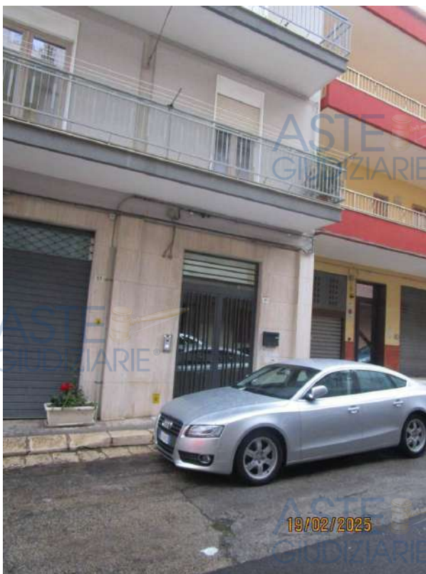
Foto n.1.1 - ingresso da via degli oleandri n.41
