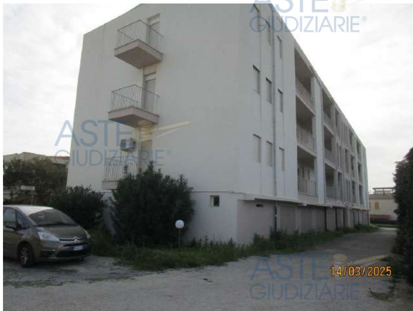
Foto n.2.3 - vista angolo via Concordia – via Gelsomini
