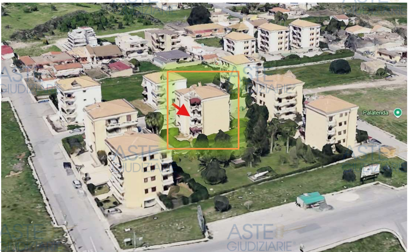
Figura 5 e 6: vista generale dell'edificio con evidenziata la posizione dell'immobile posto al secondo piano
