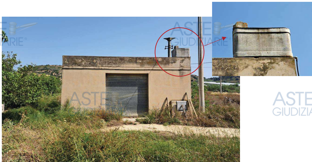
Figura n. 02.12 : Foto presenza di Serbatoio "Eternit"
