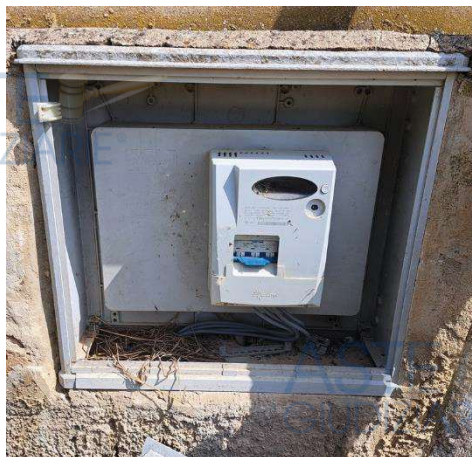
Figura n. 02.13: Foto Contatore ENEL.
