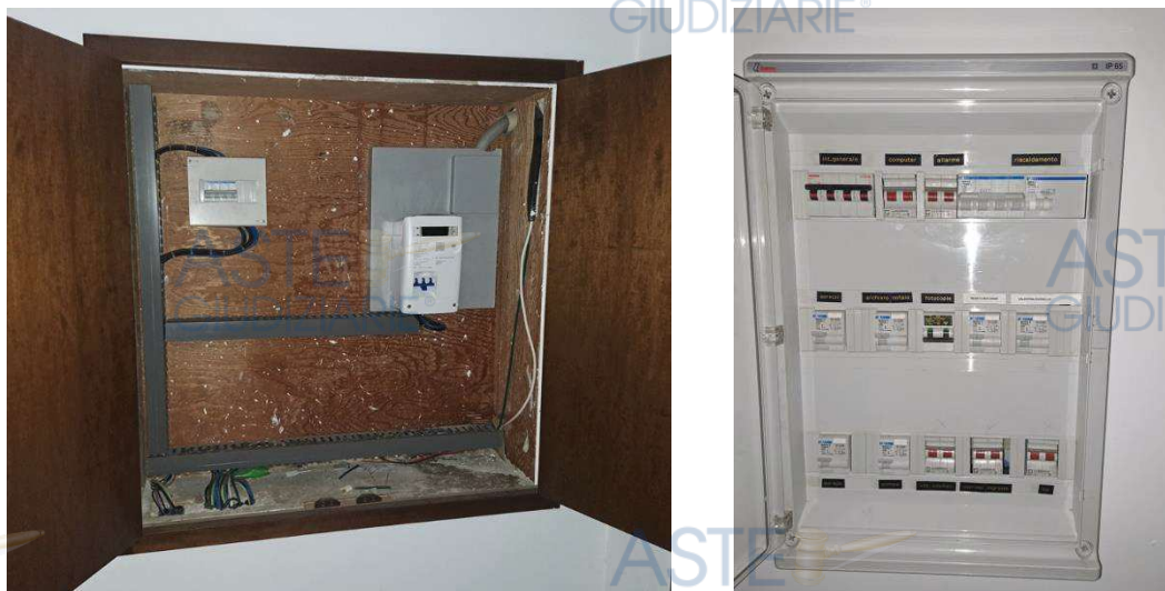
Figura n. 01.27 e n. 01.28 : Rispettivamente Quadro Elettrico Generale e Quadretto Elettrico camera
