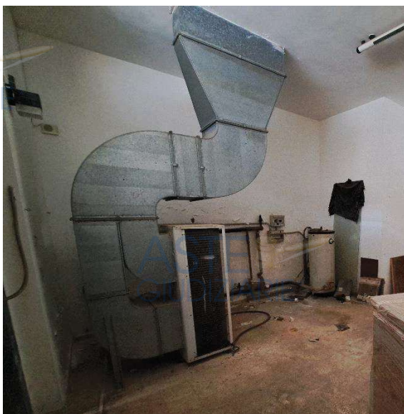
Figura n. 01.29, n. 01.30 e n. 01.31 : Impianto Termico (Pompa di calore), unità interne e radiatori.
