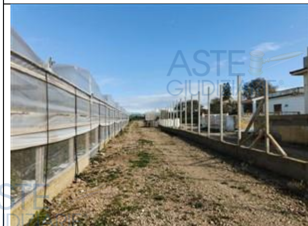
Viabilità interna, dettaglio strutture serricole e vista accesso da viabilità pubblica
