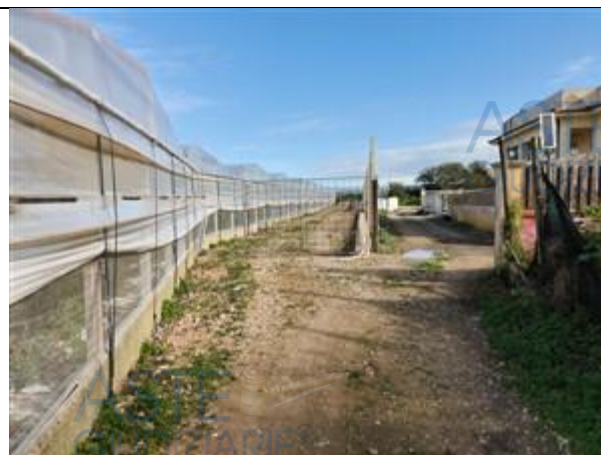
Viabilità interna, dettaglio strutture serricole e secondo accesso laterale
