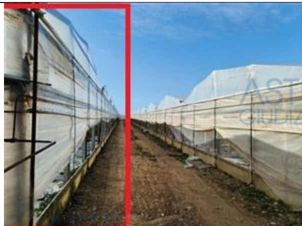
Viabilità interna e dettaglio strutture serricole
