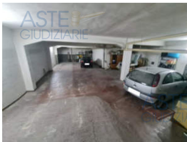
Autorimessa al piano seminterrato
