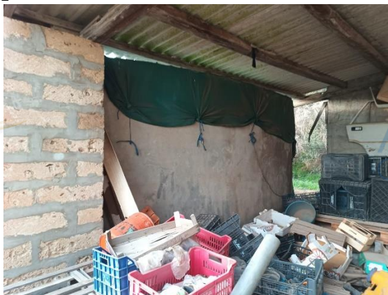
pergolato in cemento-amianto+cisterna
