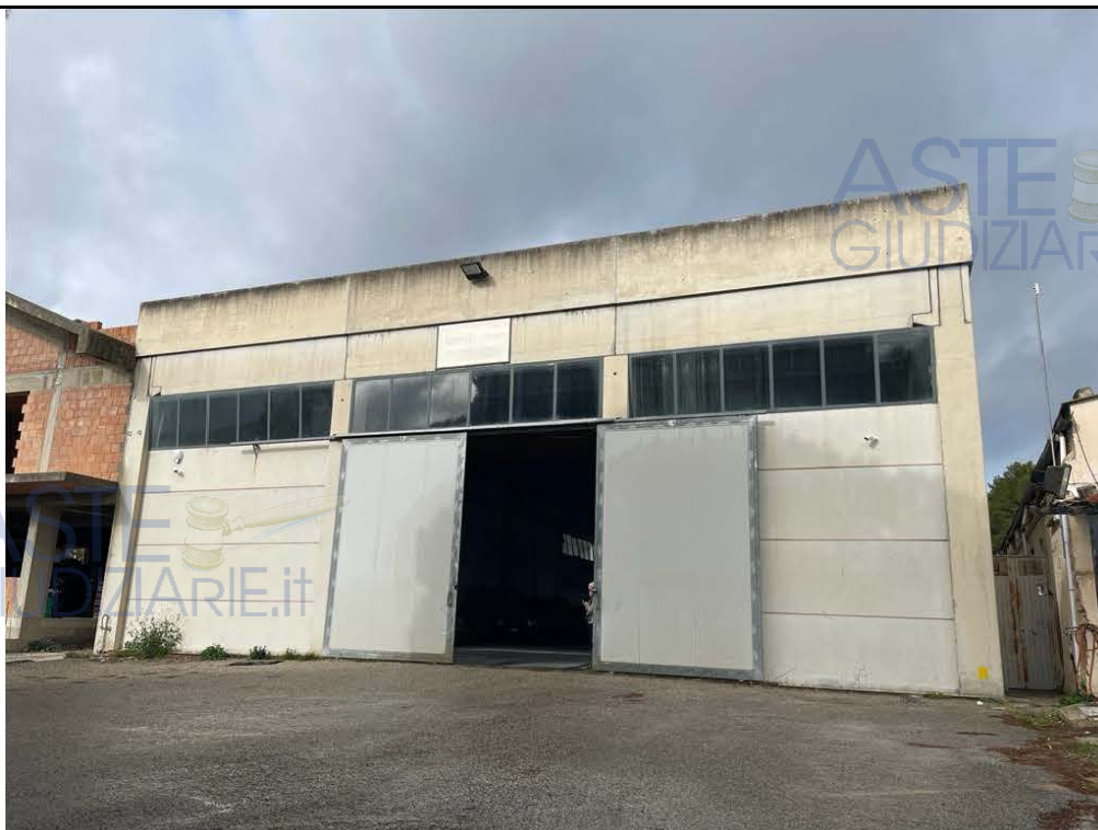
Foto 1: Prospetto principale (lato sud-est)
