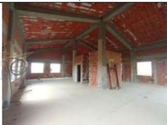
Piano primo interno lato N-E
