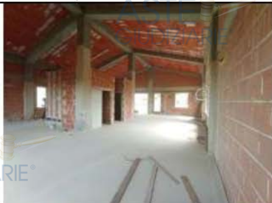
Piano primo interno lato S-E
