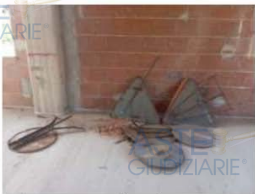
Foto 9: segnaletica di cantiere
