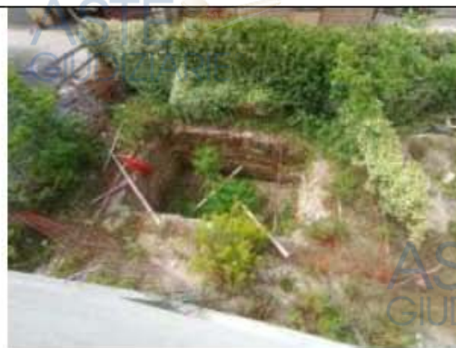
Foto 34: fossato prospetto sud
