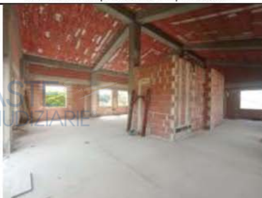
Piano primo interno lato N-W
