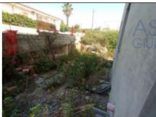
Foto 40: veduta ingresso seminterrato
