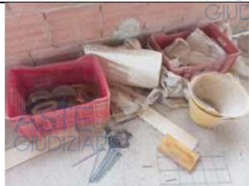
Foto 30: materiale di cantiere
