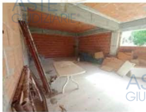
Foto 10: attrezzi di cantiere e rifiuti vari
