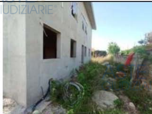
Scannafosso lato Ovest
