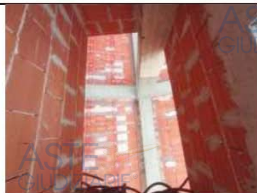
Foto 24: cielo locale tecnico
