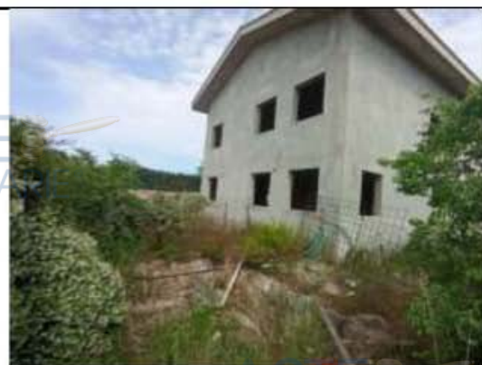
Scannafosso con scavo serbatoio lato Sud
