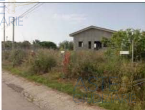
Foto 33: prospetto nord e ingresso
