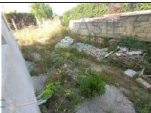
Foto 39: veduta ingresso seminterrato
