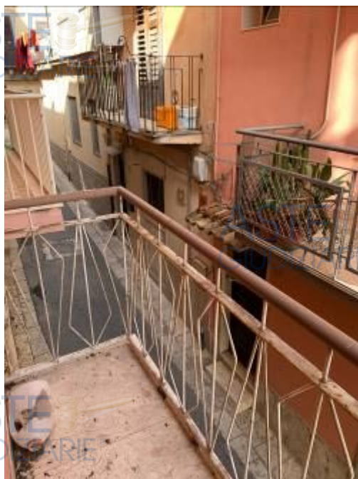
FOTO 12 Balcone Piano Primo
