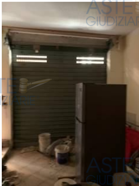
FOTO 5 Piano terra Garage
